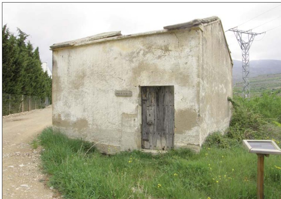
Fig. 4. Edificio del partidor de Arascués (23 de abril de 2011).
