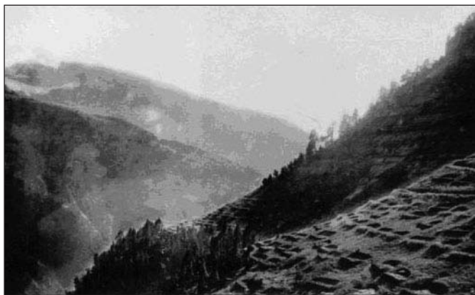
Fig. 28. Banquetas de césped en Estiviellas. (AZPEITIA, 1922a)
