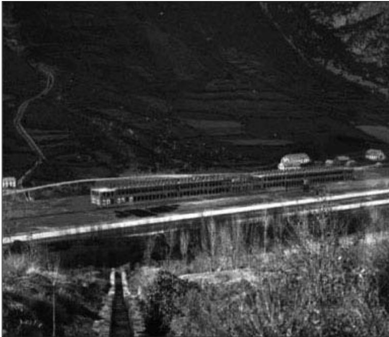
Fig. 27. Canalización del torrente de Estiviellas. (Foto facilitada por Tomás Ayerbe)
