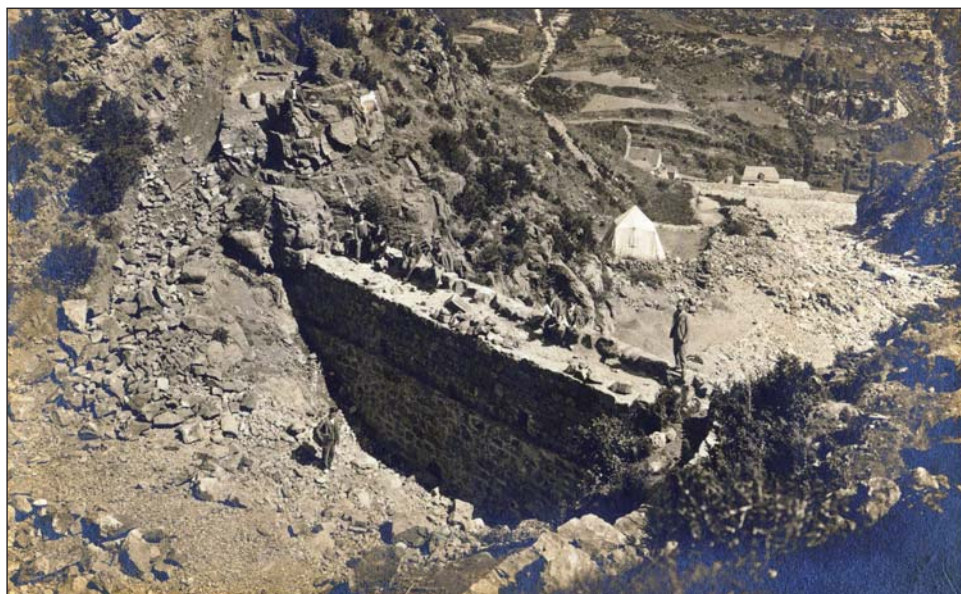
Fig. 19. Construcción del dique n.º 1 en el torrente de Los Meses. Al final del barranco se ven los tejados de la villa de Canfranc, sita en el cono de deyección. (Foto conservada en el Archivo Histórico Provincial de Huesca, sign. AHPHU-A-00943-0007)
