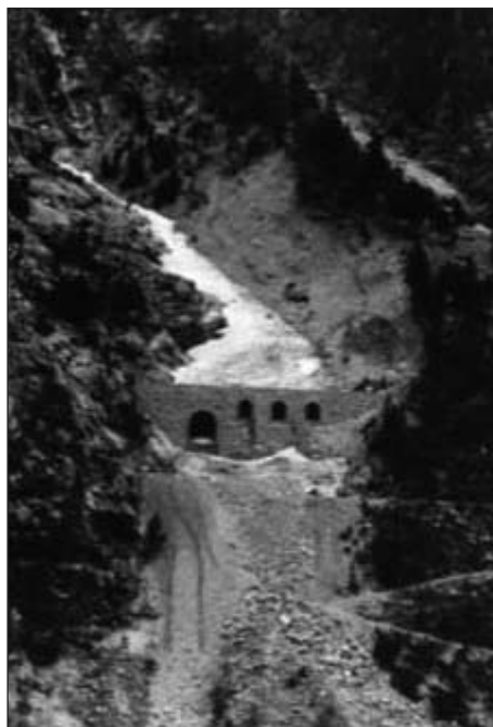
Fig. 18. Dique vacío construido en el torrente de Argualas para la defensa del balneario de Panticosa (¿1956?). (Foto: José María Ayerbe)
