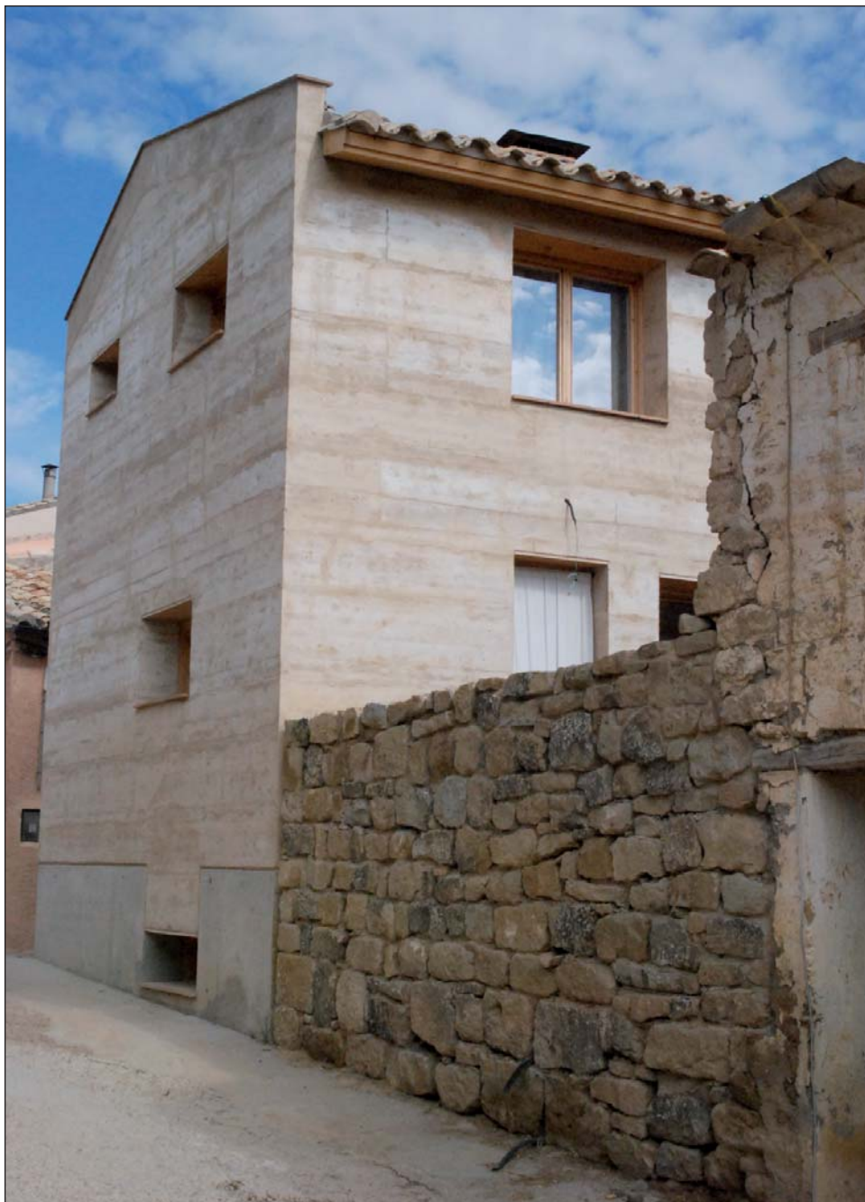
Fig. 1. Fachada suroeste de la vivienda construida en tapia.
