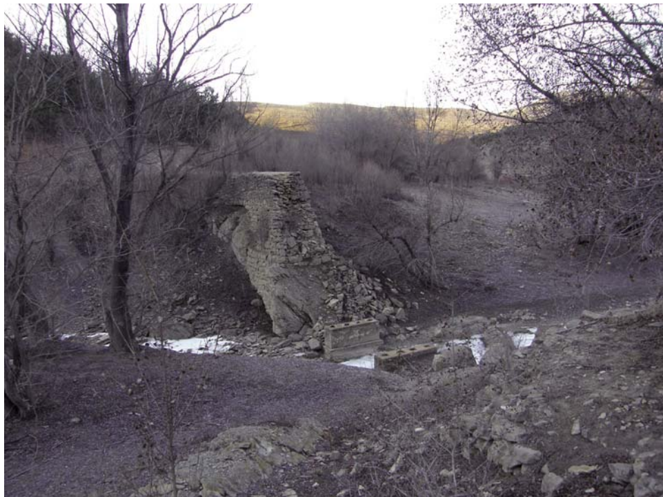
Fig. 7. Puente para vagonetas desde la cantera en Santa María de Belsué. Febrero de 2012.
