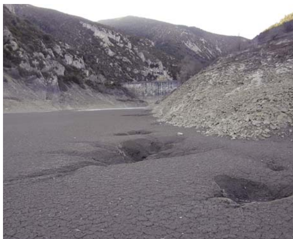
Fig. 11. Sumideros en la orilla derecha del vaso. Enero de 2012.
