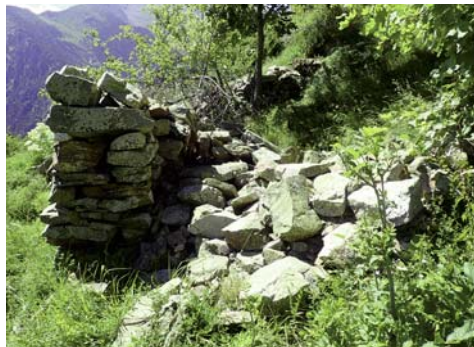
Fig. 8. Restos de edificio en las cercanías de la mina.
