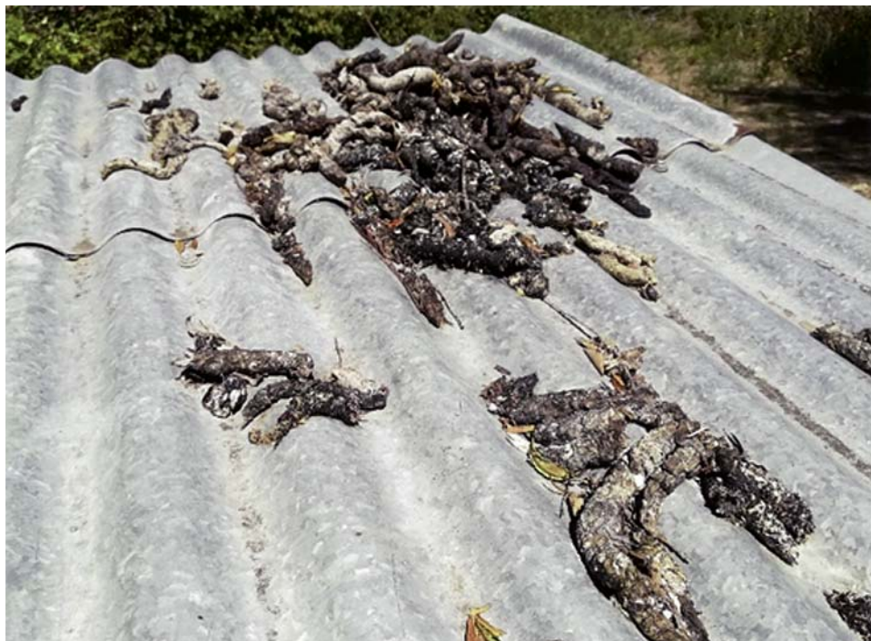
Fig. 6. Letrina de gineta en el tejadillo de una construcción en el Sendero Botánico de la Galliguera, en Biscarrués.
