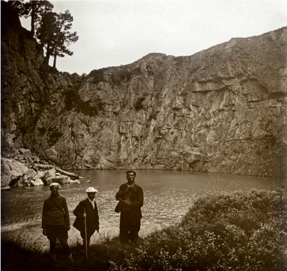
Fig. 4. El Forau d'Aigualluts actúa como sumidero en la casi totalidad de las veces, y en ocasiones especiales, como trop-plein , regulando las líneas de drenaje cuando van muy cargadas por exceso de caudal. Los conductos de drenaje se muestran incapaces de absorberlo y, en consecuencia, la capa freática comienza a subir, el nivel de filtración se estanca y empieza a acumularse agua: así podría llegar a desbordarse. (Foto: Lorenzo Almarza, ca. 1920)
