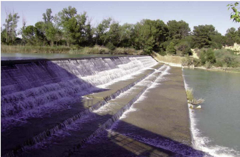
Fig. 7. Azud de Puendeluna. No se observa ninguna estructura para el descenso de nabatas .
