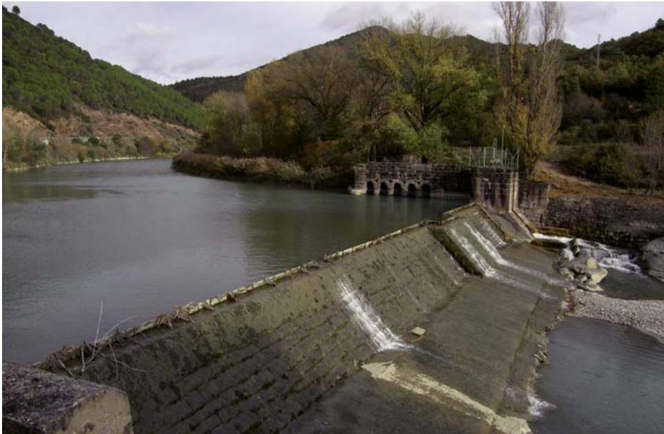
Fig. 6. Azud de la central de Carcavilla en la Garoneta, sobre el río Gállego.
