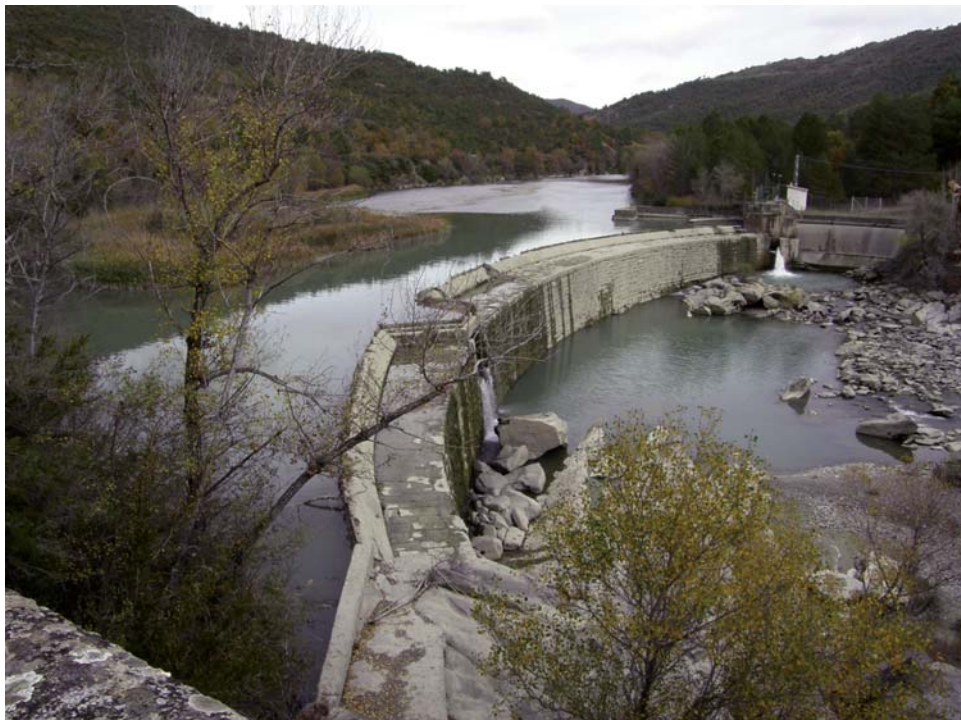
Fig. 5. Azud de la central de HidroHuesca en el río Gállego, que fue afectado por la riada de 1942.
