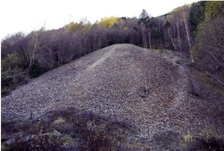
Fig. 2. Escombrera de la mina Ana.
