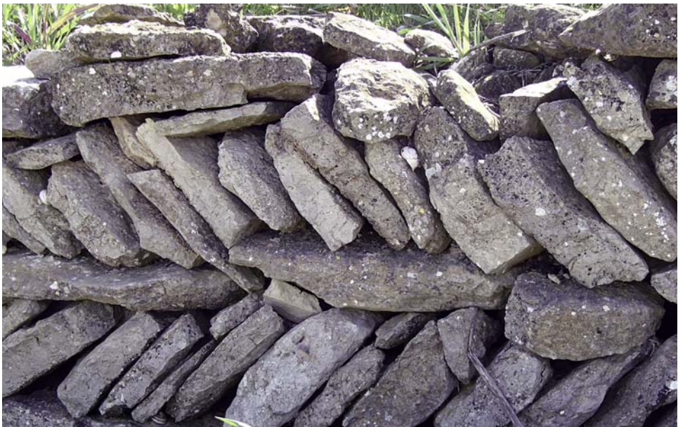
Fig. 2. Detalle de muro de protección en la cabañera de Huesca, en las cercanías de Almudévar.
