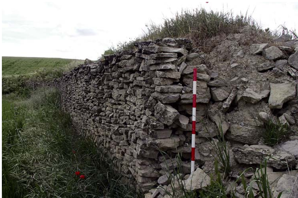
Fig. 3. Muro en el terraplén en pequeña vaguada (ETRS89 30T. X: 701212; Y: 4658560).
