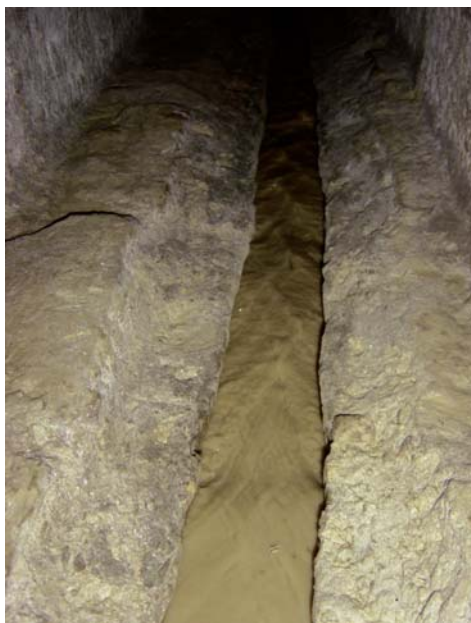
Fig. 17. Canaleta central en funcionamiento (2004).
