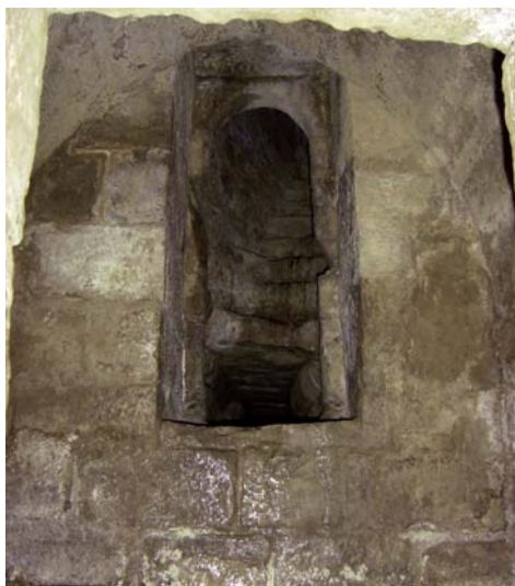
Fig. 9. Escaleras y arranque del caño desde el decantador (2004).
