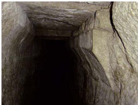
Fig. 14. Detalle del techo del caño (2004).
