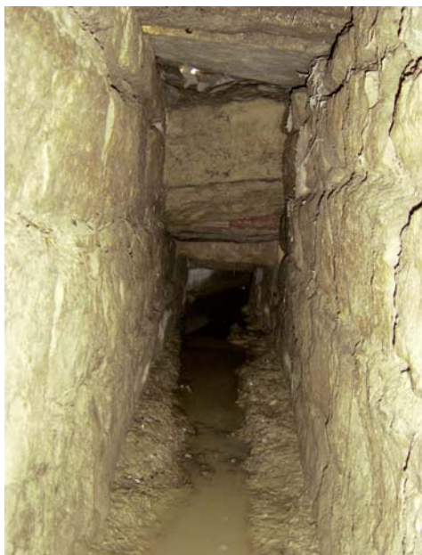
Fig. 16. Estrangulamiento del caño (2004).
