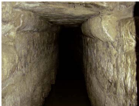
Fig. 15. Detalle del techo del caño (2004).
