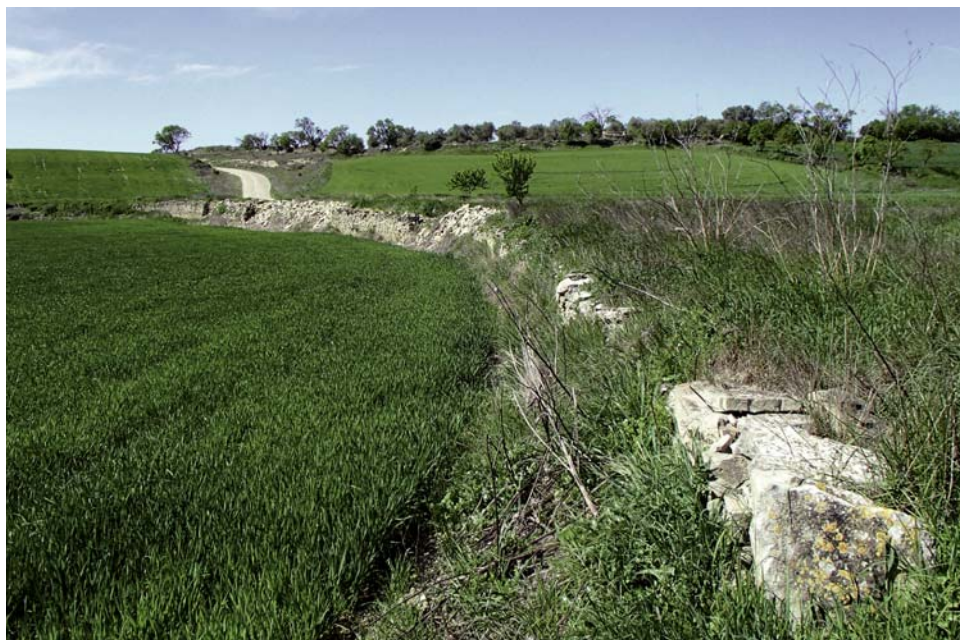
Fig. 4. Vista general del terraplén de la figura anterior.
