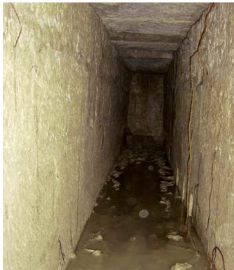
Fig. 10. Detalle del dren lateral (2004).
