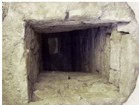
Fig. 19. Pozo desde el exterior (2004).
