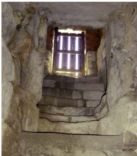
Fig. 7. Inicio de la escalera (2004).
