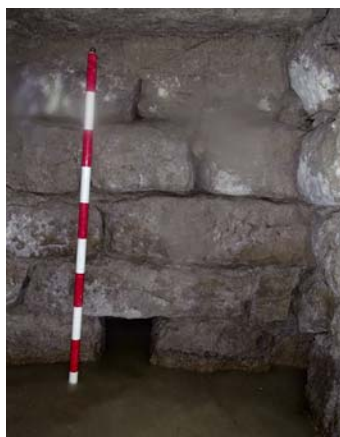
Fig. 13. Detalle constructivo del edificio (2017).
