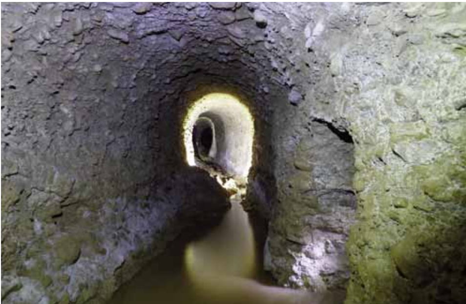
Fig. 7. Galería principal tras el dintel y salida del ramal oeste, a la derecha.
