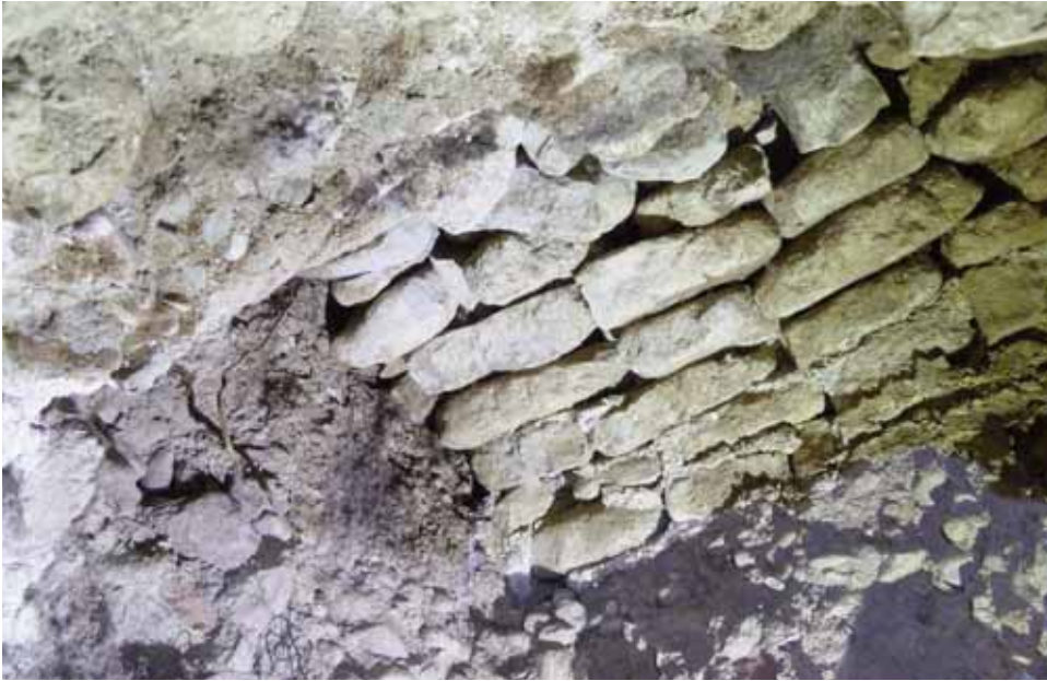
Fig. 10. Bóveda artificial en la galería oeste.
