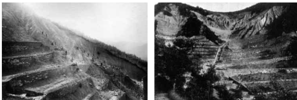
Fig. 4. Cuenca vertiente al torrente de Arratiecho hacia 1904. Trabajos de estabilización de la ladera noreste por la Sexta División Hidrológico-Forestal. (Izquierda: fotografía de la familia Ayerbe. Derecha: Fototeca Forestal Española, DGB-INIA, 2004)
