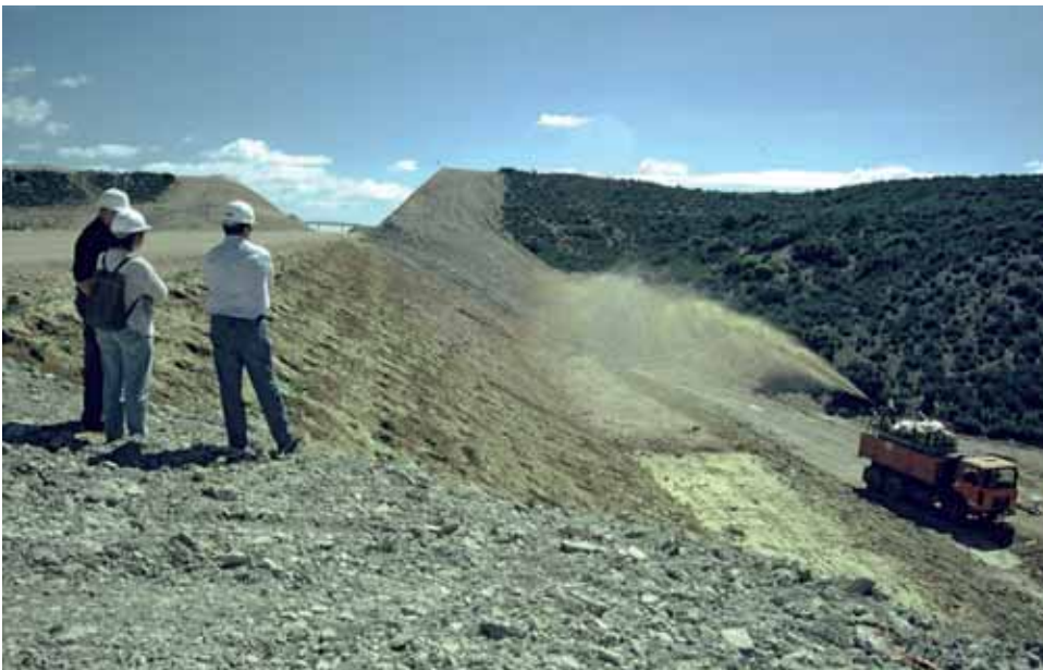
Fig. 4. La reforestación y la hidrosiembra sobre la tierra vegetal confieren estabilidad a este talud del AVE en el término municipal de Ballobar.
