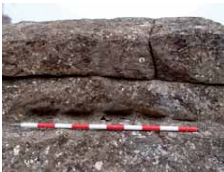
Fig. 4b. Huellas de cuña. Canteras de Fornillos (0715931/4673149).
