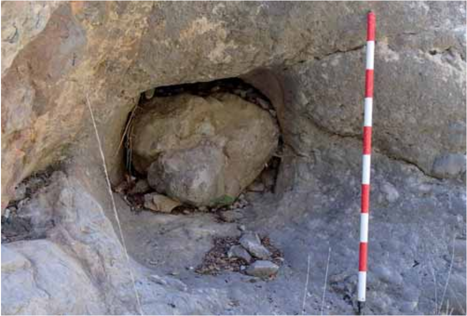
Fig. 5. Toma de agua en la orilla izquierda.
