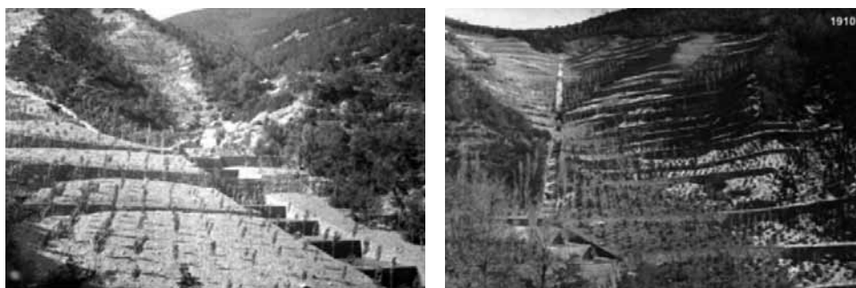
Fig. 5. Cuenca vertiente al torrente de Arratiecho hacia 1910. Encauzamiento del cauce principal y obras y trabajos de reforestación realizados en el área de recepción de la cuenca. (Fototeca Forestal Española, DGB-INIA, 2004)
