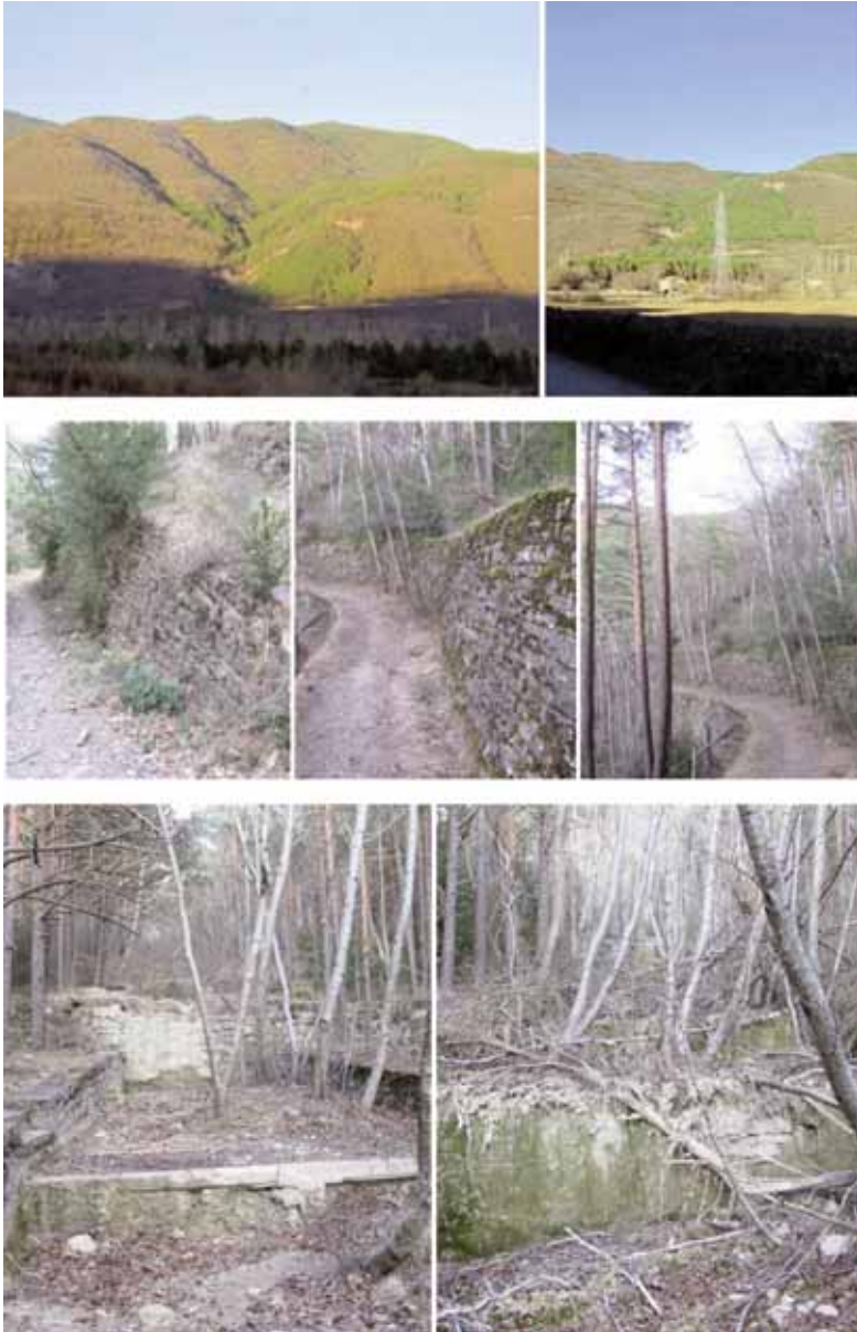
Fig. 17a. Cuenca vertiente al torrente de Arratiecho en marzo de 2012. Imágenes superiores: vistas generales de la cuenca. Imágenes centrales: estado actual de los trabajos de estabilización de la ladera noreste ejecutados a comienzos del siglo XX. Imágenes inferiores: estado actual del encauzamiento del torrente, ejecutado también a comienzos del siglo XX, en el primer tramo de la garganta de la cuenca.
