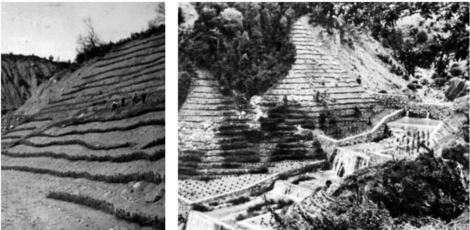
Fig. 12. Trabajos de estabilización del tramo de garganta del torrente de Arás. Izquierda: ejecución de fajinas para sujetar la morrera en la garganta del torrente a mediados del siglo pasado. (Fotografía de la familia Ayerbe) Derecha: imagen de 1963 que muestra una visión completa de las obras de sujeción del lecho del torrente, con diques de consolidación y fijación de sus laderas vertientes directas mediante fajinas y reforestación. (Fototeca Forestal Española, DGB-INIA, 2004)
