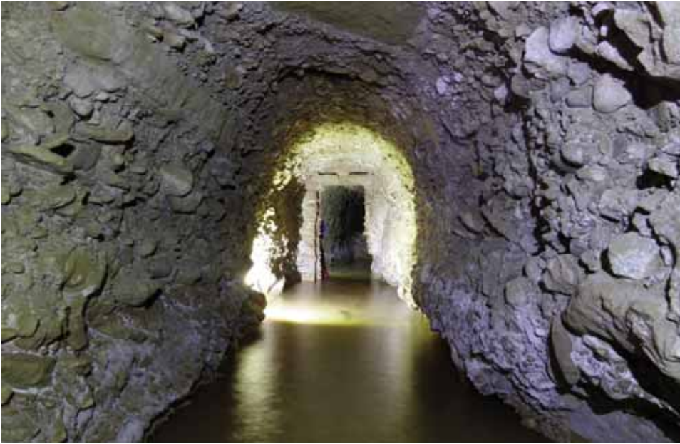
Fig. 6. Galería principal. Tramo en obra.
