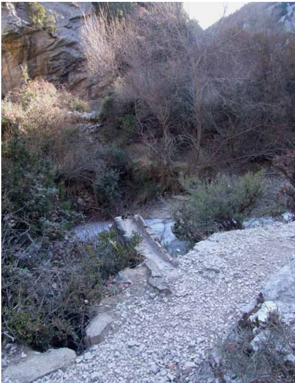
Fig. 23. Restos del arranque que soportaba los baciones indicados en la figura 22. En primer plano, la acequia pasa completamente desapercibida por el relleno de piedras y tierra. En frente, el Huerto d'Angela se disimula oculto tras la vegetación. (Fecha: 16/12/2007)
