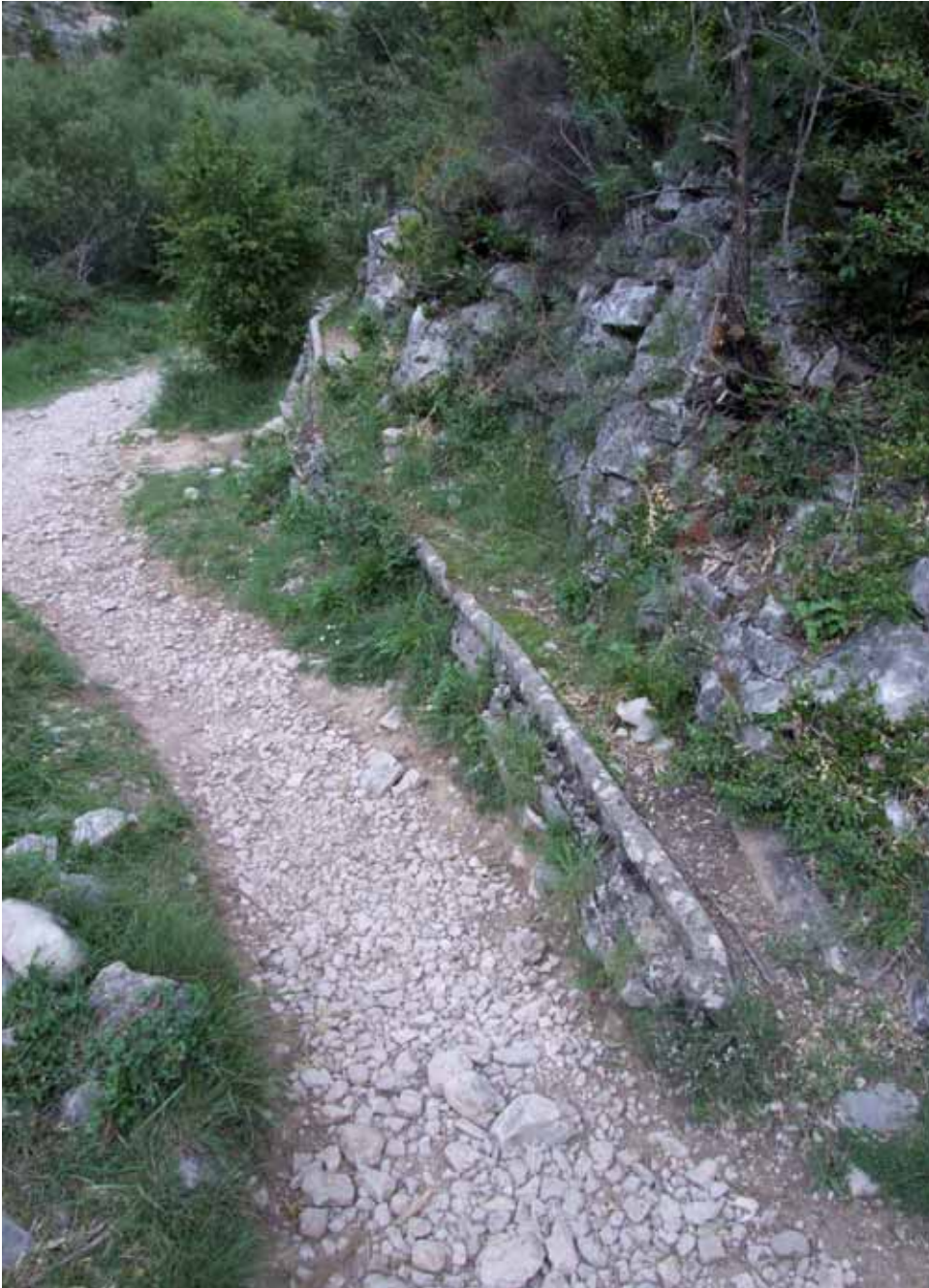
Fig. 20. Tramo final de la misma canaleta. (Fecha: 17/5/2009)
