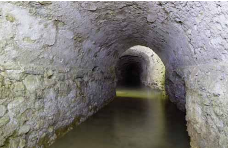
Fig. 5. Galería principal. Tramo en obra.
