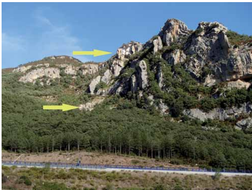
Fig. 10. Caída de rocas, hacia 2014, desde la cárcel de Ordás al bosque de repoblación sobre la A-23.
