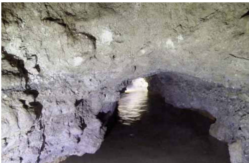
Fig. 9. Tramo inicial en la galería oeste.
