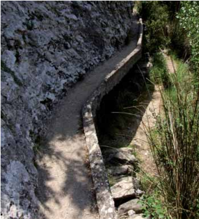
Fig. 25. La canaleta de obra que conduce al Huerto Francho. (Fecha: 23/5/2010)
