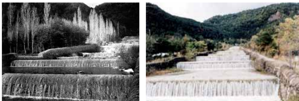
Fig. 13. Dos vistas del canal escalonado de tramos erosionables en el cono de sedimentación del torrente de Arás. Izquierda: 1963. Derecha: 1993. (Fototeca Forestal Española, DGB-INIA, 2004)
