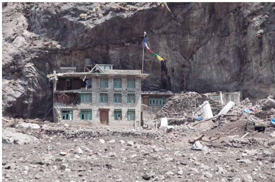
**Fig. 11.** Edificio protegido bajo el cortado señalado con un círculo en la figura 10. Sobrevivió a la avalancha, pero posteriormente fue alcanzado en la esquina oeste por una gran piedra.
