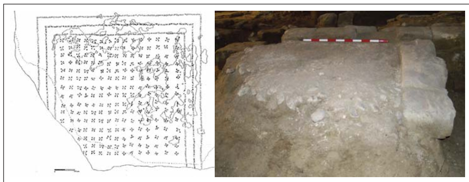
Fig. 15. Restitución del pavimento de opus signinum según JUSTE (1994: 133-171) y fotografía del estado actual.
