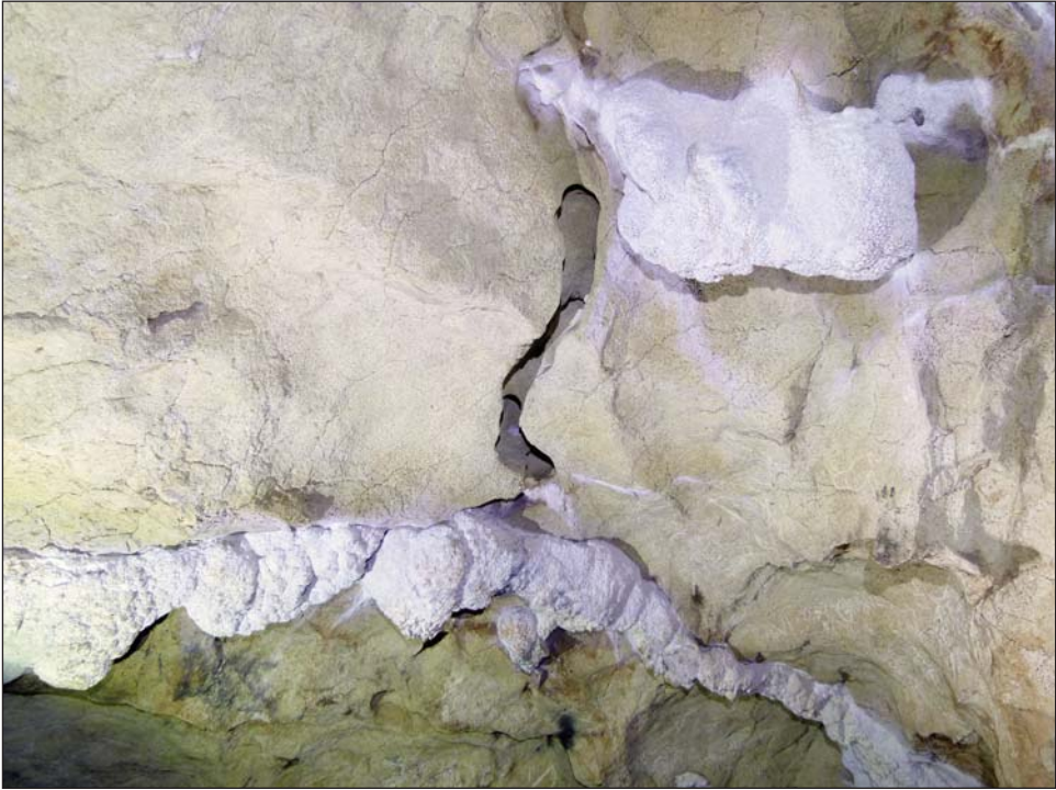
Fig. 3. Protocanal en el techo de la sala inicial.
