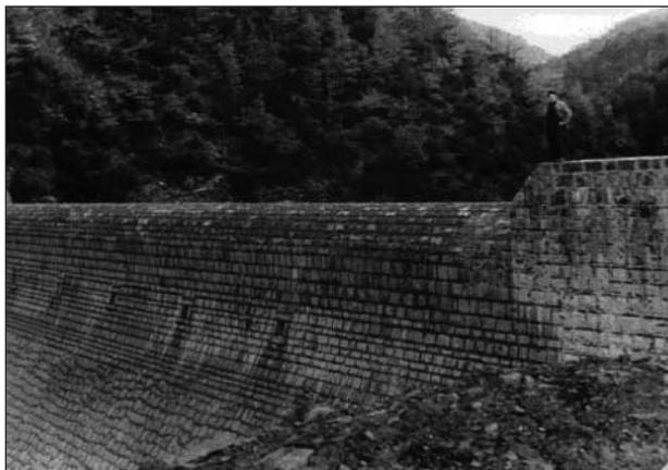
**Fig. 16.** Gran dique de mampostería hidráulica construido en el torrente de Sía en 1962, según la memoria de los trabajos realizados en ese año por la Dirección General de Montes, Caza y Pesca Fluvial. (Foto: José María Ayerbe)
