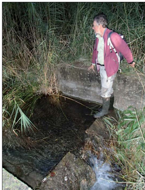
Fig. 4a. Vertedero en el arroyo de Isarre.
