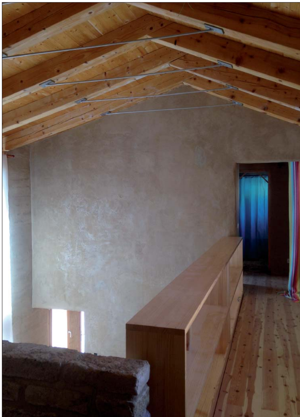
Fig. 2. Interior de la vivienda construida en tapa.
