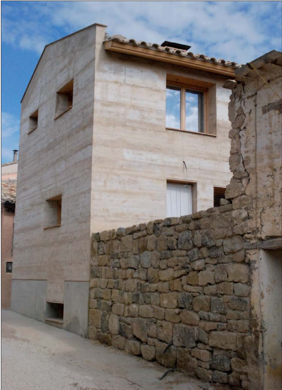
Fig. 1. Fachada suroeste de la vivienda construida en tapia.
