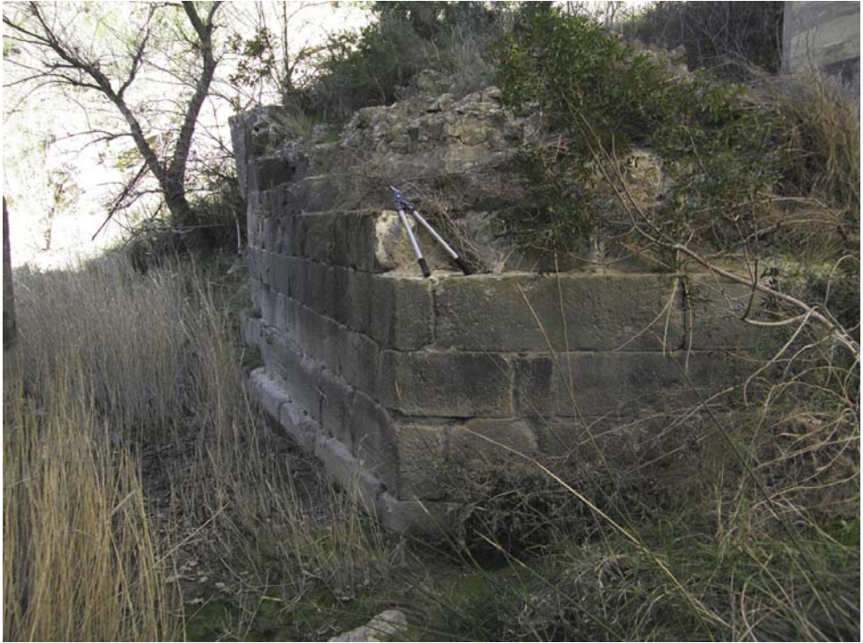
Fig. 2. Restos de pilar del puente antiguo en su orilla derecha (la referencia tiene 0,8 metros de largo).
