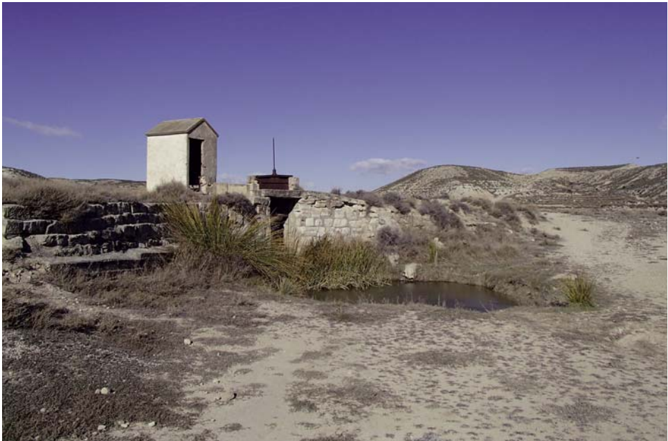
Fig. 5. Azud y partidor ( las tajaderas ) del barranco de Ballesteros.
