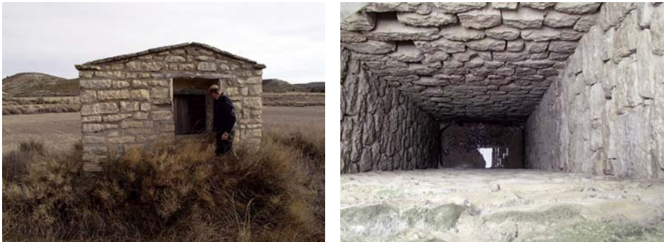
Fig. 8. Pozo Romallal (izquierda); interior del pozo (22 de diciembre de 2017) (derecha).
