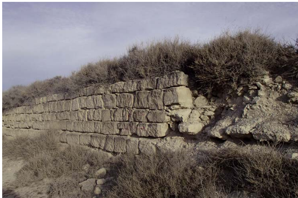
Fig. 2. Muro de bancal y vista del relleno entre Castejón de Monegros y La Madre.
