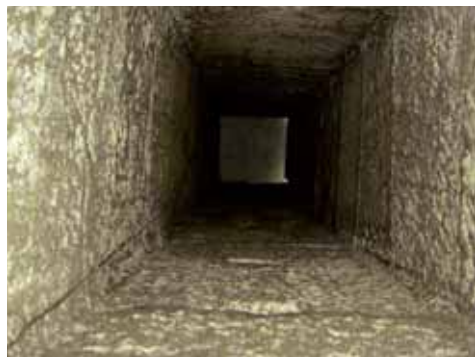
Fig. 18. Pozo de ventilación desde el caño (2004).
