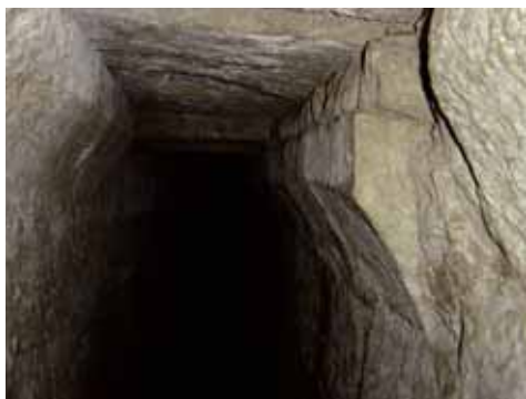
Fig. 14. Detalle del techo del caño (2004).
