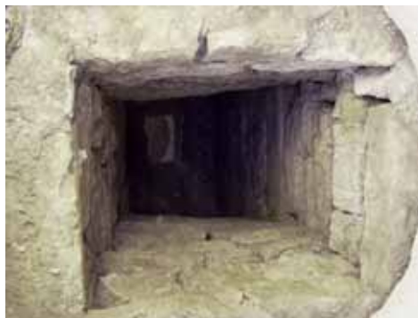
Fig. 19. Pozo desde el exterior (2004).
