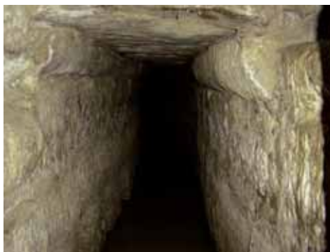
Fig. 15. Detalle del techo del caño (2004).
