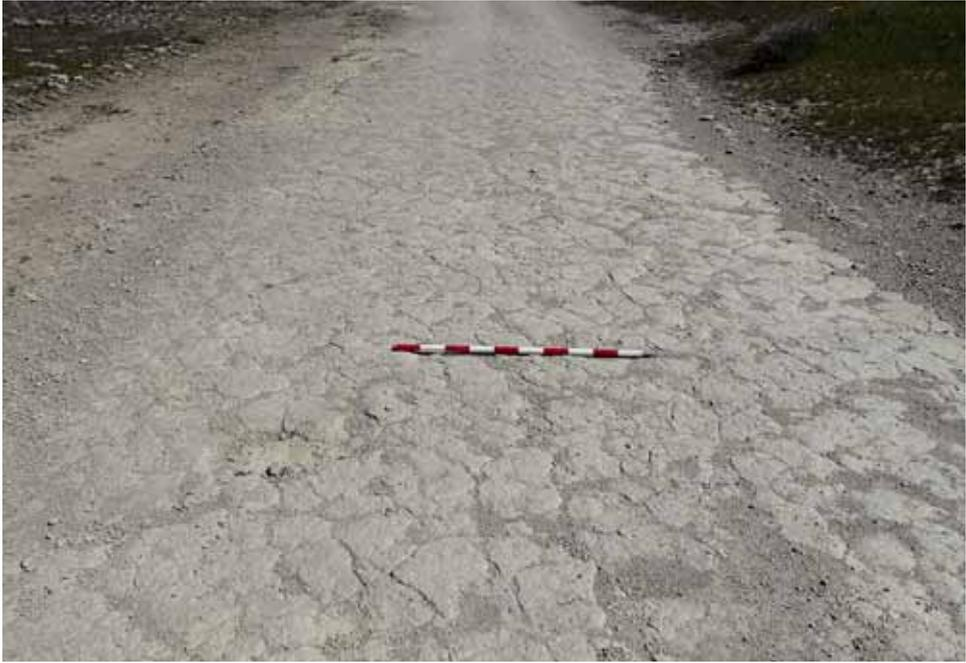
**Fig. 5.** Firme natural en la cabañera (ETRS89 30T. X: 702005; Y: 4658957).
