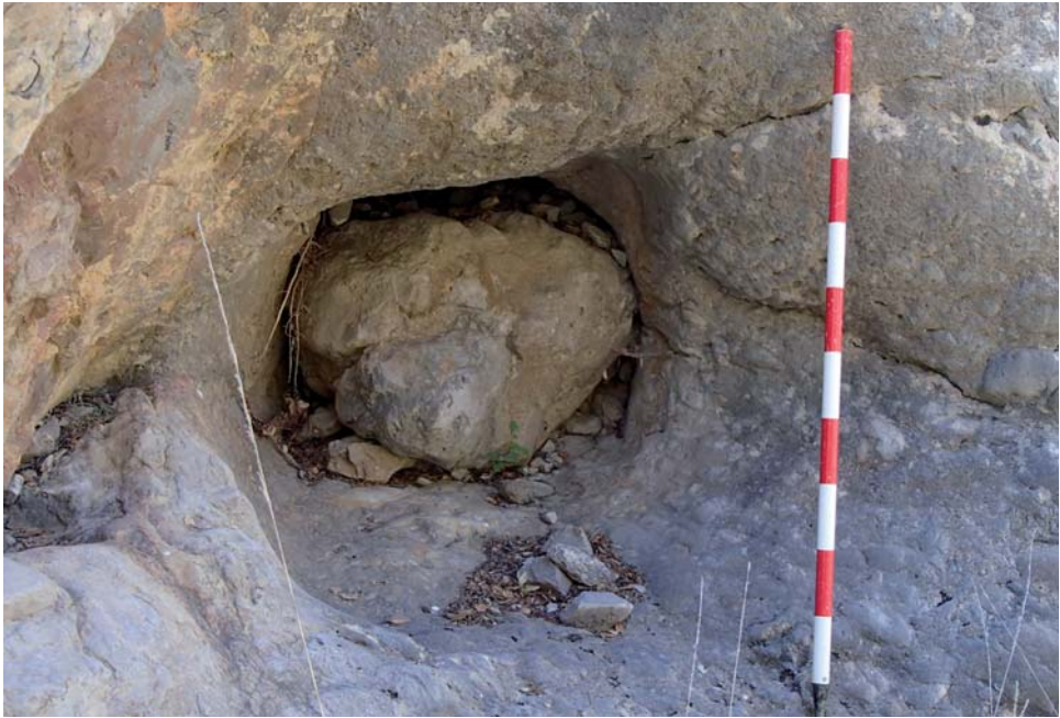
Fig. 5. Toma de agua en la orilla izquierda.
