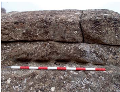
Fig. 4b. Huellas de cuña. Canteras de Fornillos (0715931/4673149).
