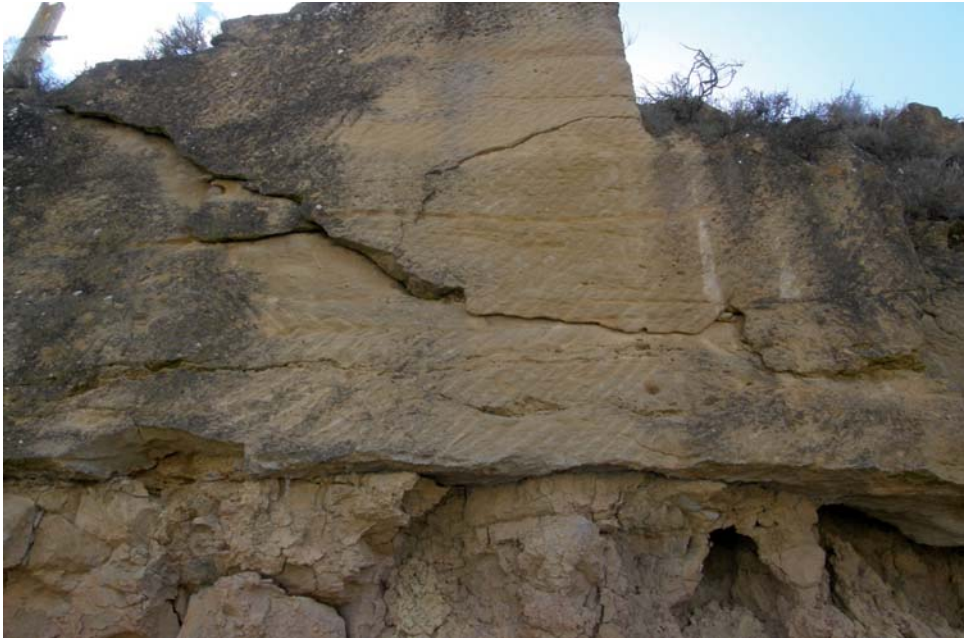
Fig. 39. Marcas de excavación en la ladera norte del cerro de las Mártires (714638/4669181).
