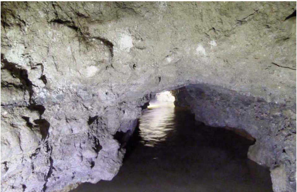
Fig. 9. Tramo inicial en la galería oeste.
