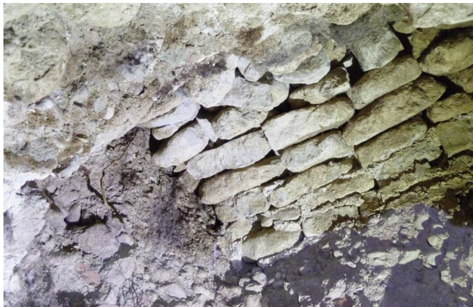
Fig. 10. Bóveda artificial en la galería oeste.
