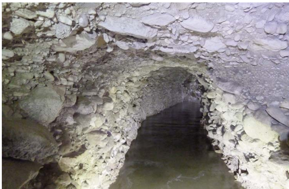
Fig. 4. Galería norte, cerca del final.
