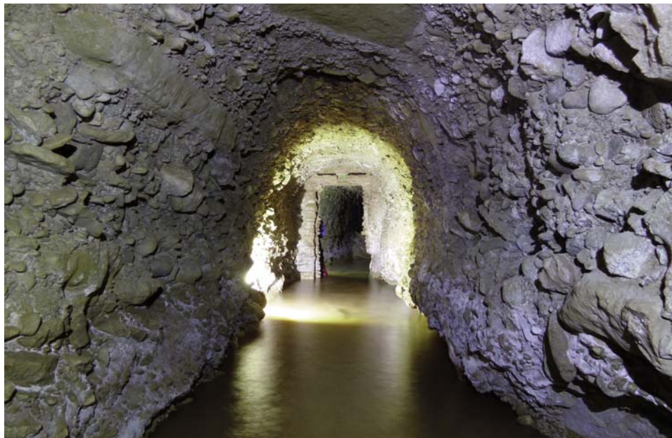
Fig. 6. Galería principal. Tramo en obra.
