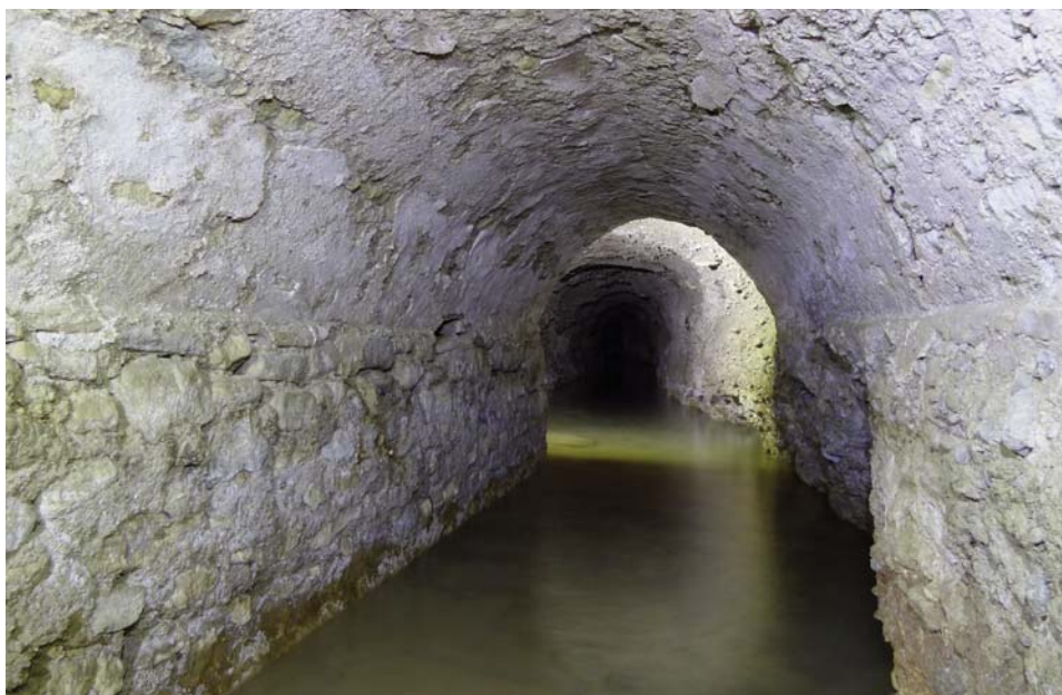
Fig. 5. Galería principal. Tramo en obra.
