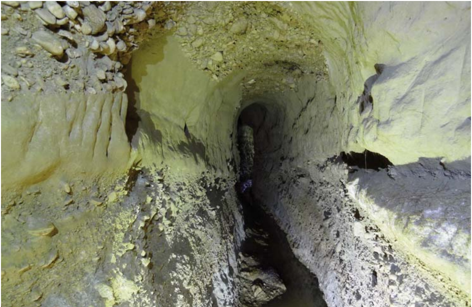
Fig. 8. Galería principal. Zona interior con cambio en la litología y restos de banqueta lateral.
