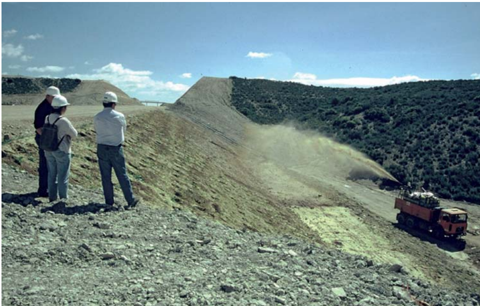
Fig. 4. La reforestación y la hidrosiembra sobre la tierra vegetal confieren estabilidad a este talud del AVE en el término municipal de Ballobar.
