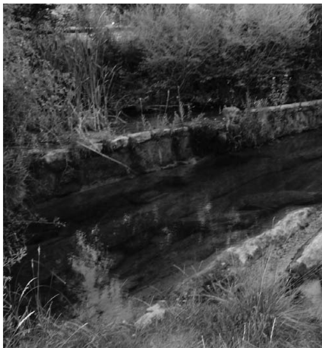
Figura 1. Azud del molino-central en Nocito.
