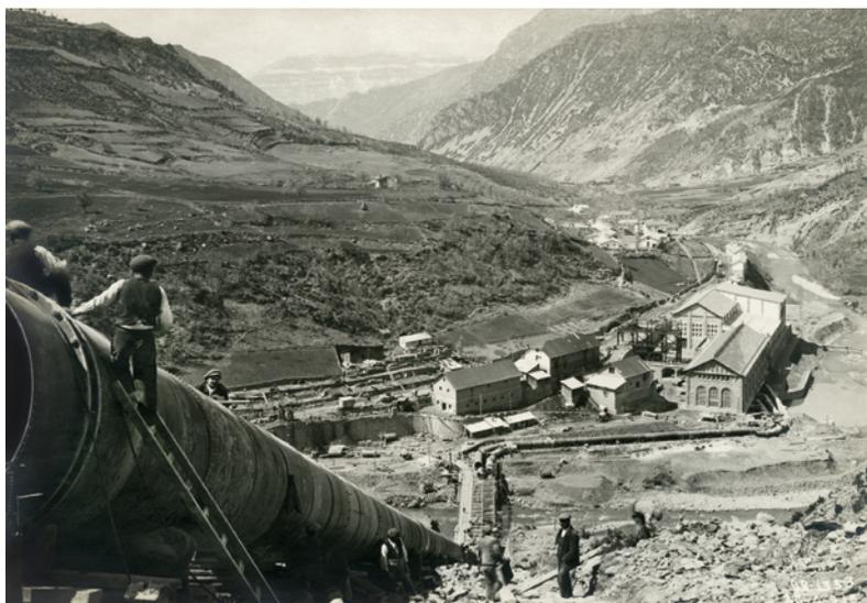
Ensamblaje de la tubería de presión de la central de Seira, construida entre 1912 y 1918.
