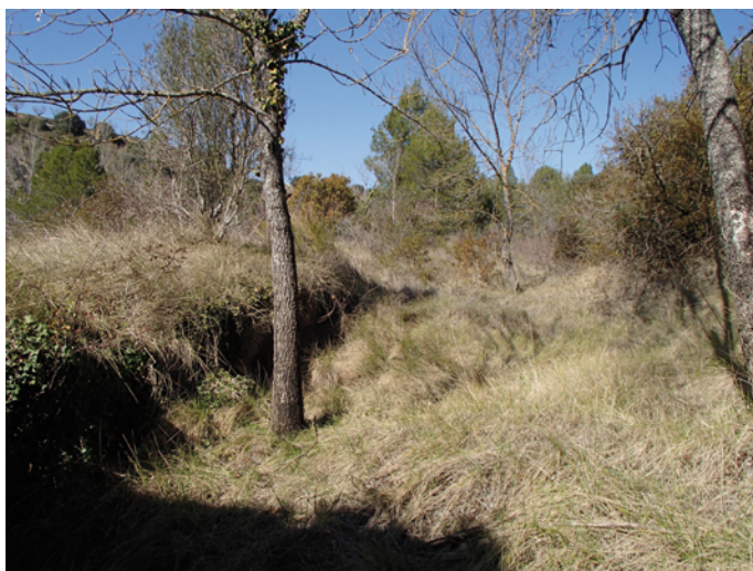
Figura 15. Canal de alimentación del molino.
