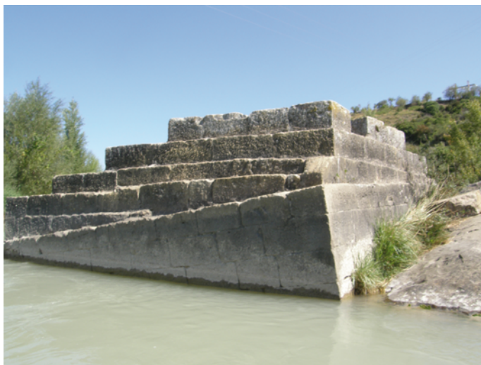
Figura 16. Vista de detalle de la pilastra del Pontaz apoyada en una roca. Se observa el apoyo sobre una roca, aguas abajo, y la inclinación de una primera fase.
