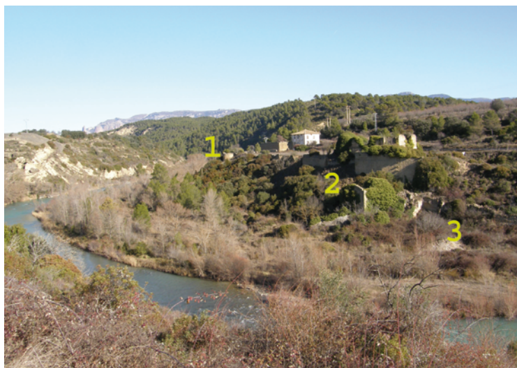
Figura 3. Vista del Molinaz desde la caseta del Tensino (orilla derecha). 1) Resto de la torre circular; 2) torre de planta cuadrada; 3) ubicación del antiguo molino.
