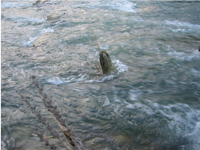
Figura 12. Restos de estacas verticales en el azud del Molinaz.
