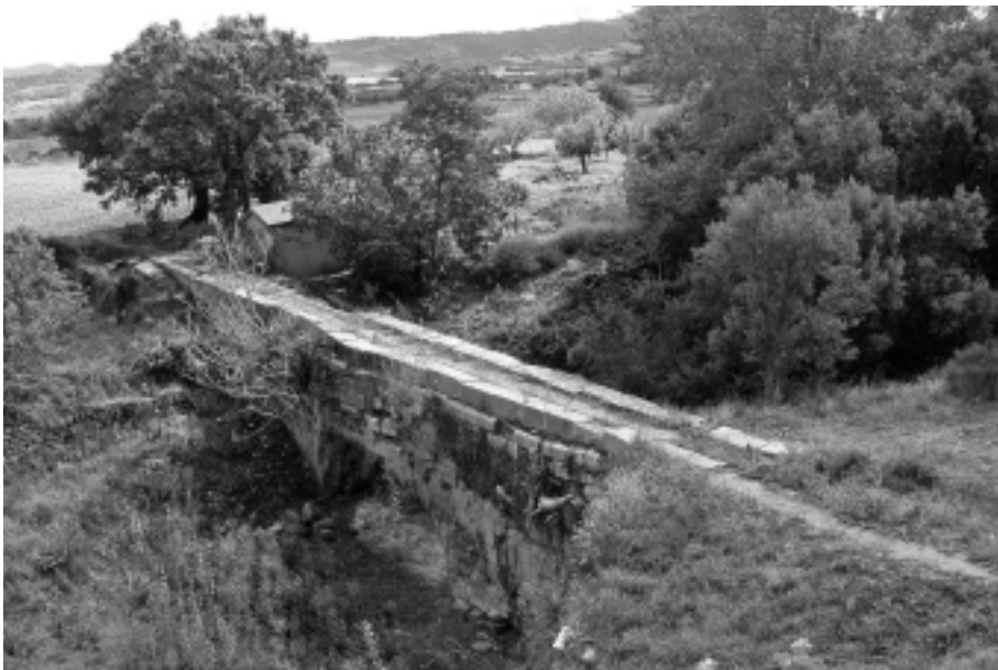
Figura 5. Acueducto en Arascués, reciclado tras la modernización de los riegos.
