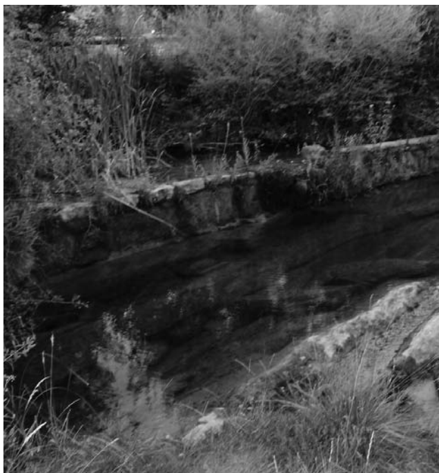
Figura 1. Azud del molino-central en Nocito.
