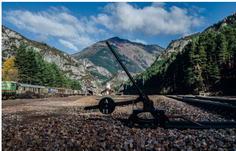
Figura 19. Fotografía realizada desde el depósito de locomotoras en dirección norte. Se aprecian los trabajos realizados para limpiar la parte posterior de la estación y los vagones estacionados en el lateral. (Colección particular de Borja Lera Aused)
