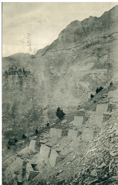
Figura 4. Fotografía de las obras realizadas para frenar las avalanchas y proteger la explanada. (Demarcación hidrográfica del río Aragón. Fototeca de la Diputación Provincial de Huesca)
