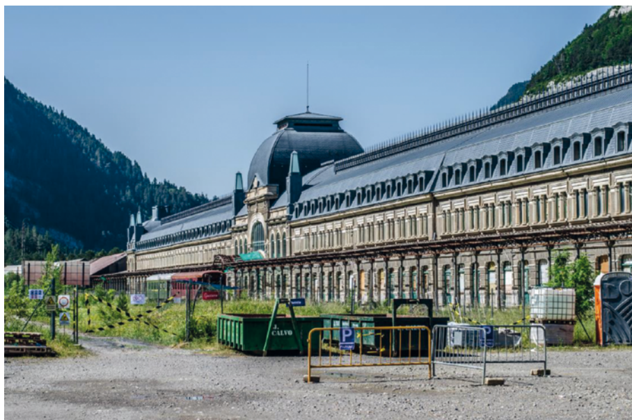
Figura 13. Fotografía de la parte posterior de la Estación Internacional de Canfranc durante el comienzo de las obras. (Colección particular de Borja Lera Aused)
