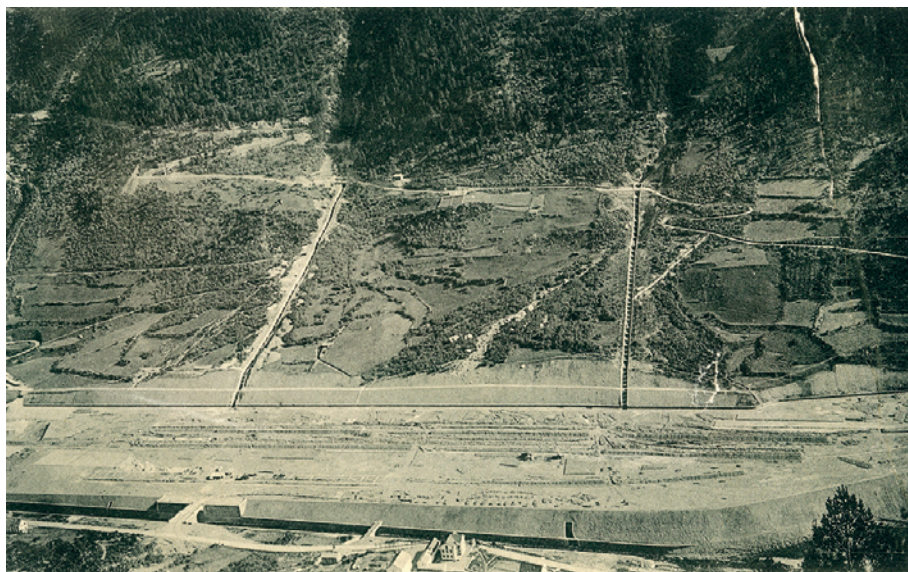
Figura 3. Fotografía de las obras de explanación de Los Arañones. (Demarcación hidrográfica del río Aragón. Fototeca de la Diputación Provincial de Huesca)
