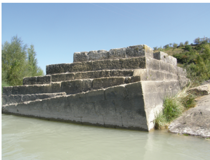
Figura 16. Vista de detalle de la pilastra del Pontaz apoyada en una roca. Se observa el apoyo sobre una roca, aguas abajo, y la inclinación de una primera fase.
