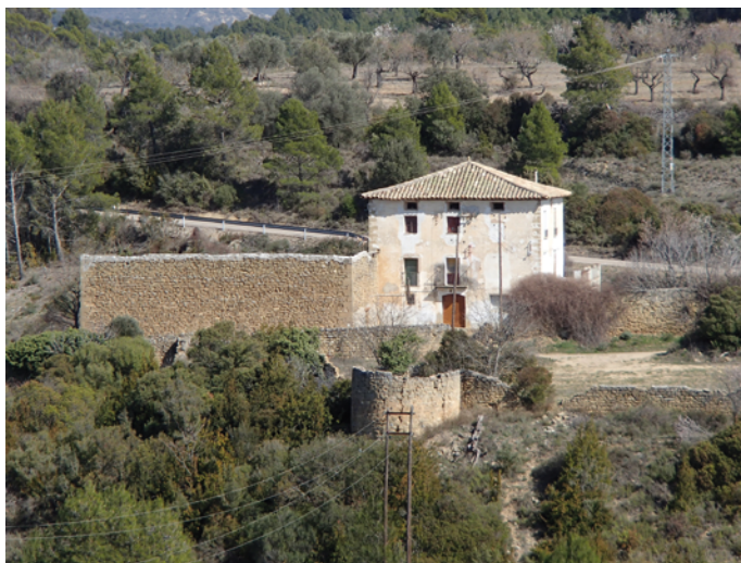
Figura 5. Antiguo mesón y edificio adjunto, y restos del torreón en primera fila.
