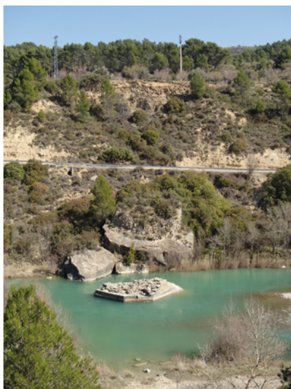
Figura 16. Vista de detalle de la pilastra del Pontaz apoyada en una roca. Se observa el apoyo sobre una roca, aguas abajo, y la inclinación de una primera fase.
