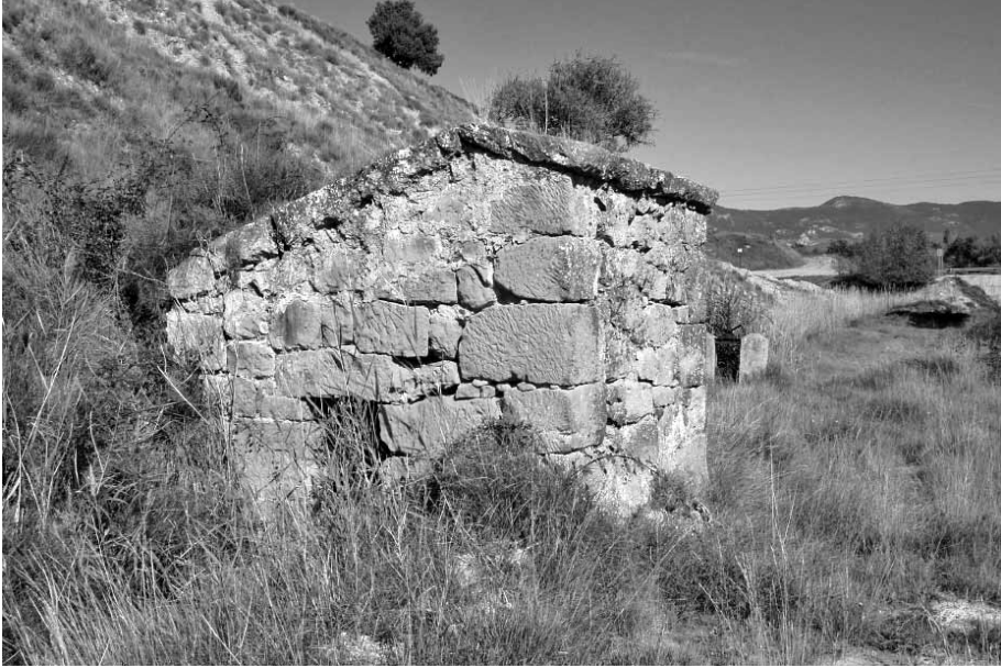
Caseta de aforo de la acequia de Mondod-Rosel.
