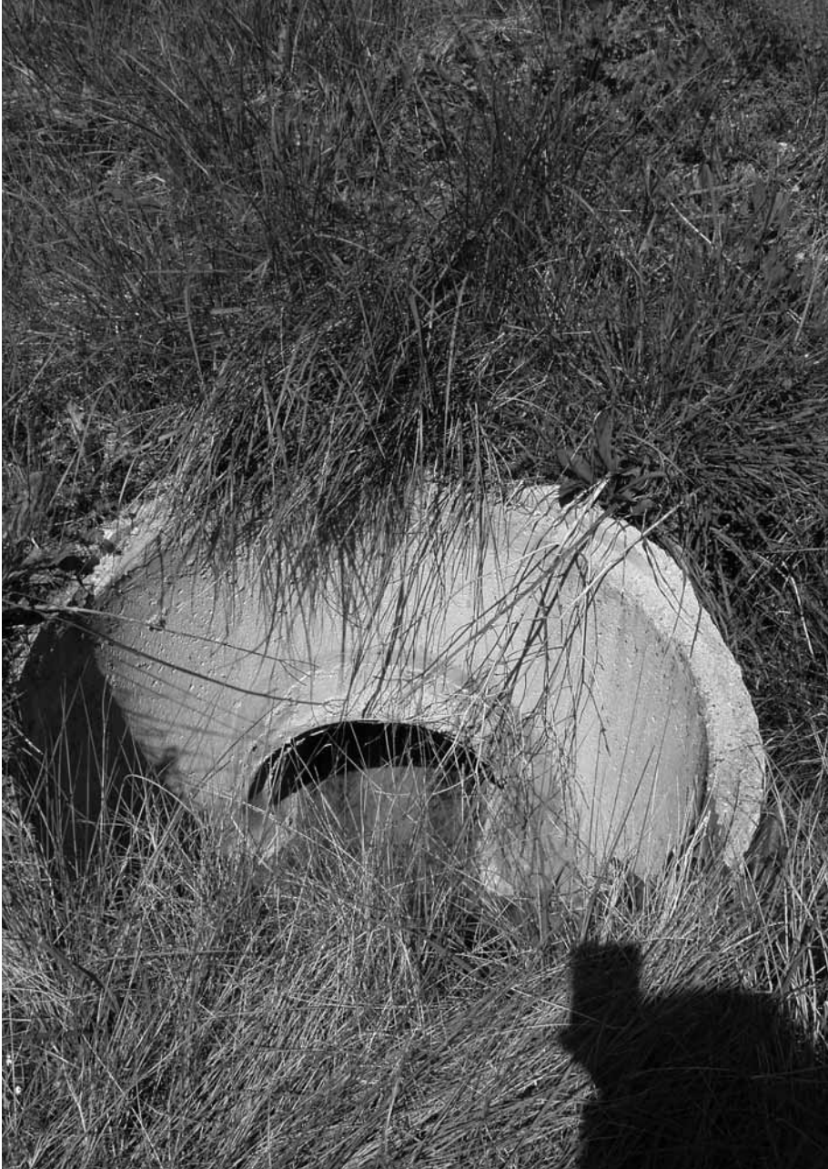
Pozo de registro de Villabietre.
