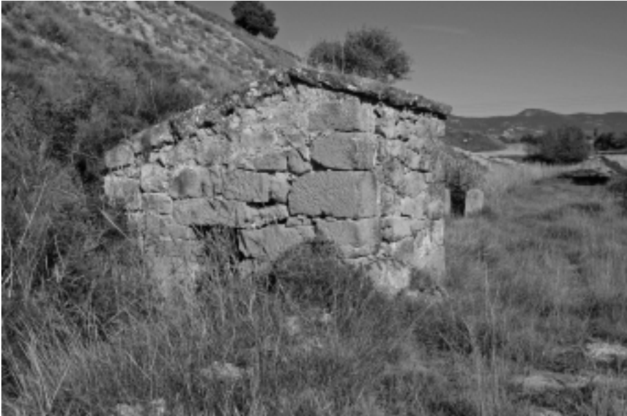
Figura 3. Caseta de aforo de la acequia de Mondod-Rosel.
