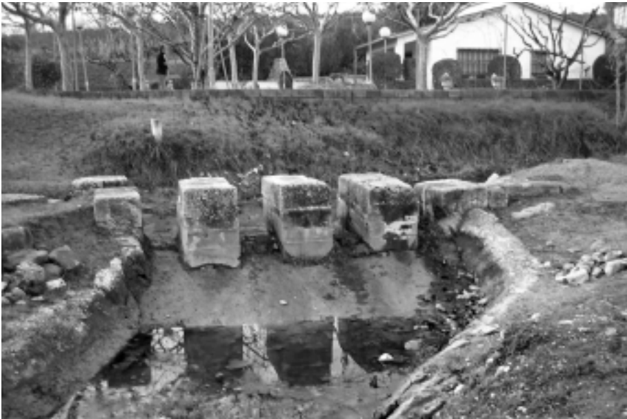
Figura 6. Sistema de compuertas conocido como las Pasaderas de Cortés , de apertura alternativa: compuertas 1 y 3 ó 2 y 4.
