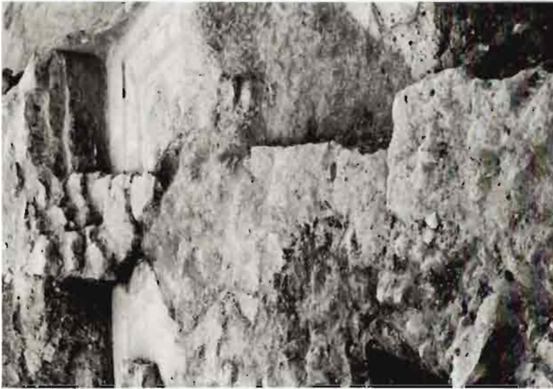
Lám. 1.1. Uno de los muros del Antiguo Hospital Provincial que cimentaba directamente sobre el mosaico.
