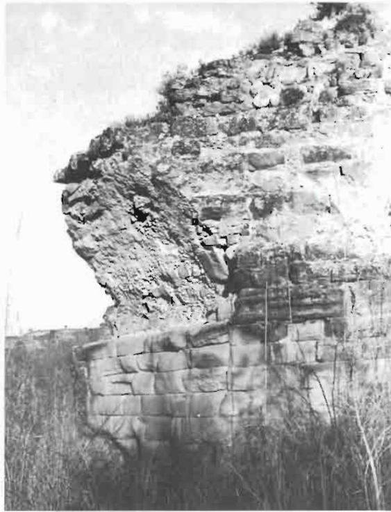
Lámina 4. Puente romano de Castejón.
