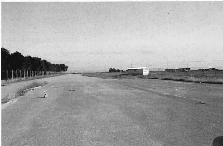
Fig. 13. Vía. Tramo IV. Asfaltado. Junto al Centro de Enseñanzas Integradas (tapia límite de la calzada).
