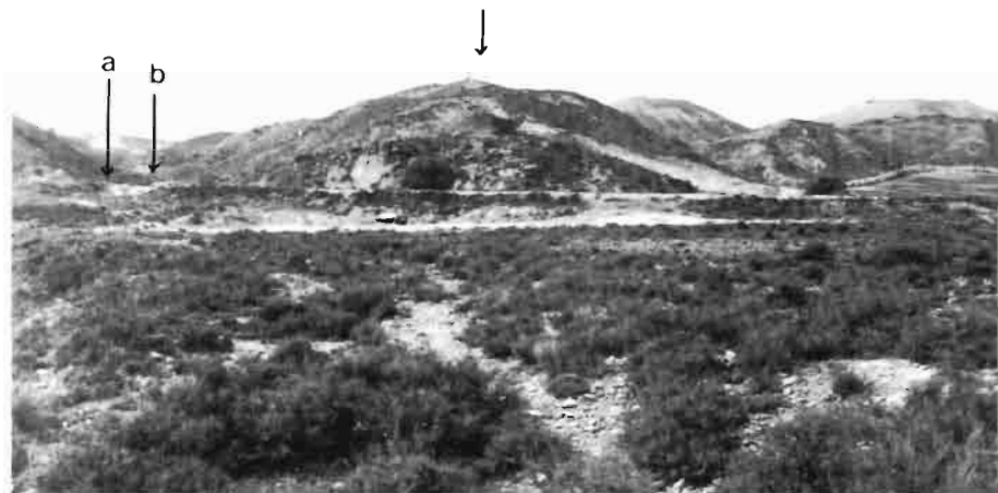
Fig. 16. Barranco de San Jorge I. Situación general. Situación de la presa (a). Trazado de la vía (b).
