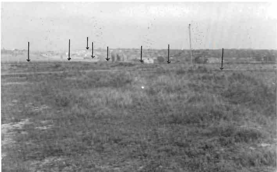
Fig. 8. Vía. Fin del tramo II y comienzo del tramo III, cortados por el camino de Orús. En primer plano, castillo de Torén.
