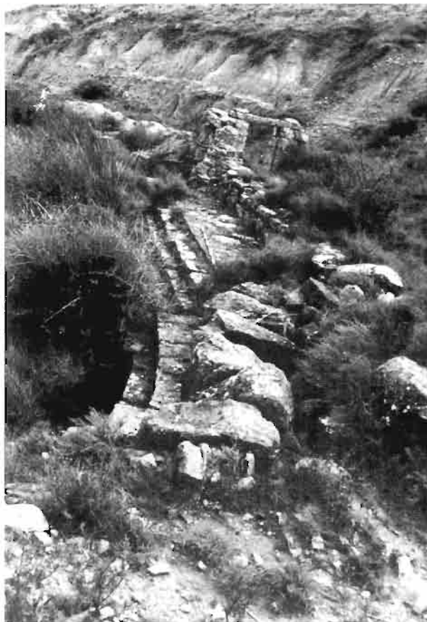
Fig. 21. Presa del barranco de San Jorge. Detalle de la estructura.
