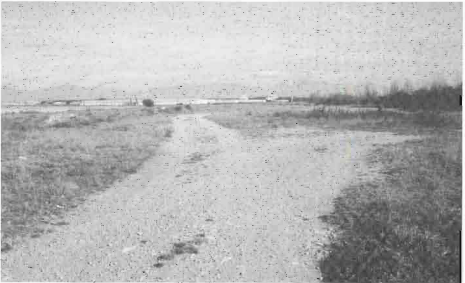
Fig. 12. Vía. Tramo IV. Zona de las granjas.
