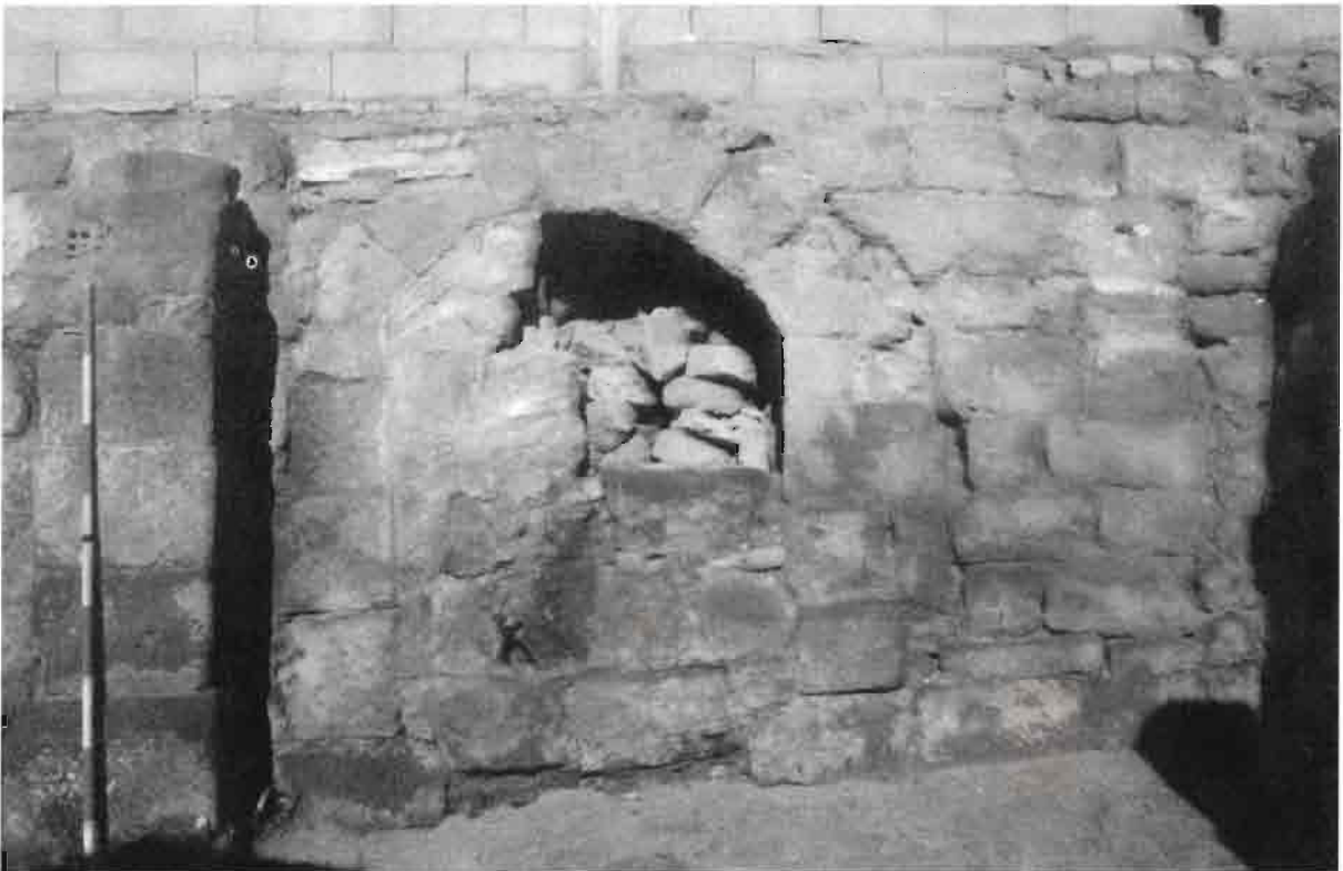
Fig. 42. Acceso tapiado en el edificio subterráneo central.
