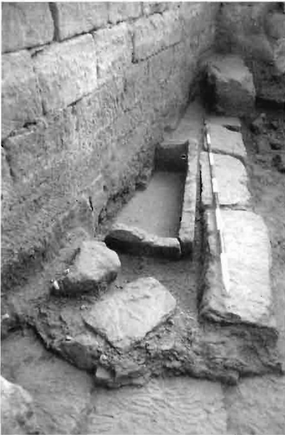
Fig. 26. Casa. Depósito de la estancia «h».
