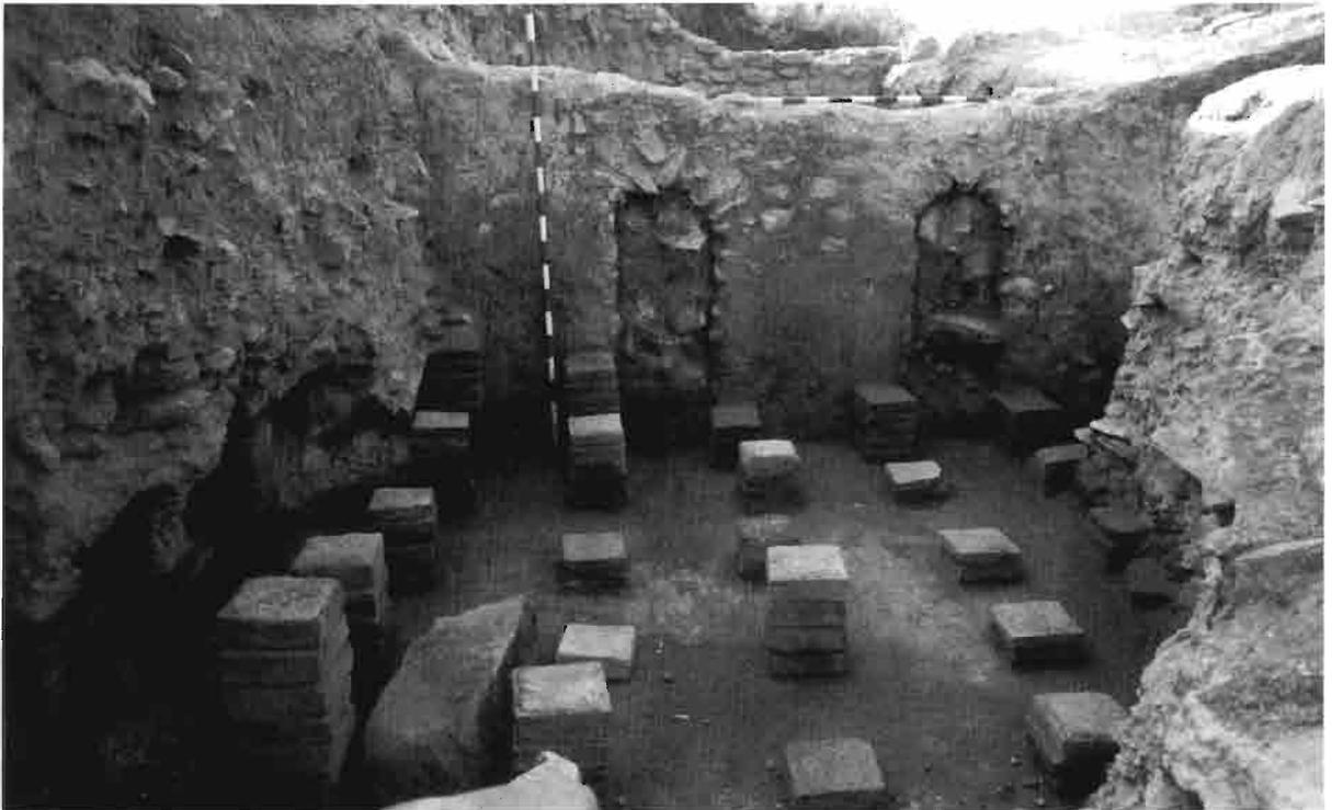
Lám. I. Hypocaustum del tepidarium de las termas II. Obsérvense las *pilae* de ladrillo y el muro de separación con el *caldarium*, realizado en *opus incertum*, así como los arcos abiertos en el mismo para el paso del aire caliente.
