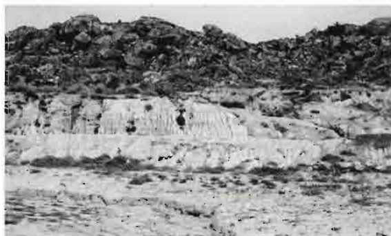
Foto 55. Estado actual de la ladera sur de Faceras.
