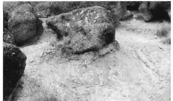
Foto 34. Detalle del desplazamiento de los bloques de arenisca por las laderas sobre el estrato arcilloso por soliflujión en el yacimiento de Terramolins.
