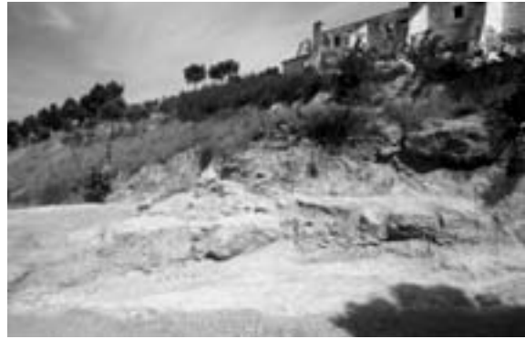
Fig. 6. Basamento de la torre defensiva desde el este, situada en la entrada del foso (J. Medina, Servei d'Audiovisuals del IIEI).
