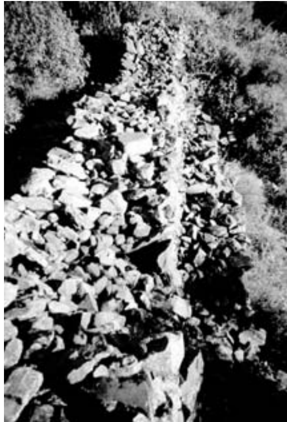
Fig. 6. Detalle de los contrafuertes de la muralla.
