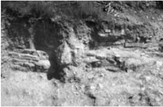
Fig. 5. Detalle del muro de protección de la ladera hecho con piedras calcáreas sobre el basamento de los bloques de grava cementada (J. Medina, Servei d'Audiovisuals del IIEI).
