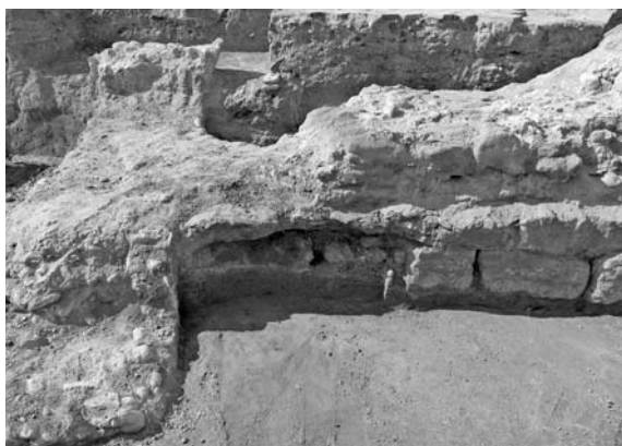
Fig. 10. Vista de la unidad constructiva 11.
