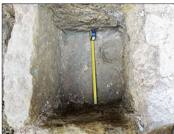
Fig. 16. Detalle del interior de la pileta. Se observan los restos de la capa de enlucido de mortero de cal que otorgaba la impermeabilidad a la construcción y la pequeña cazoleta que permitía la limpieza de los residuos acumulados en el fondo.
