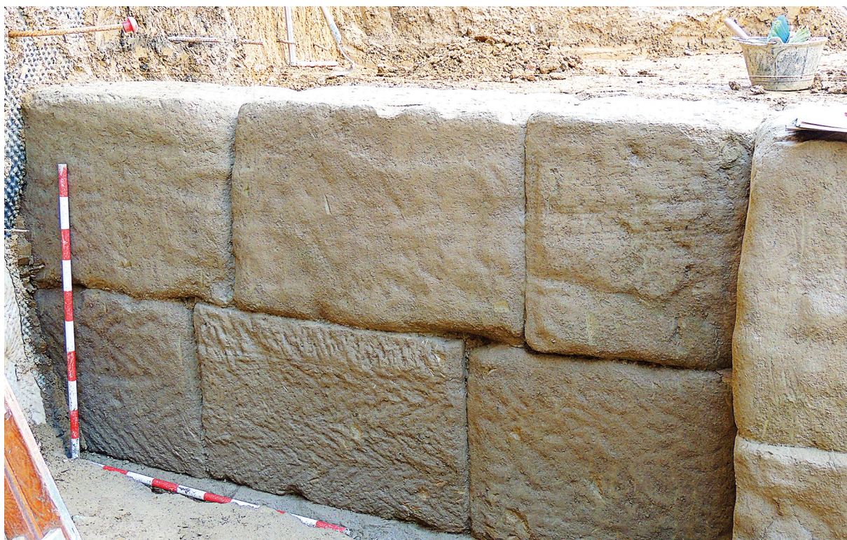
Fig. 23. Detalle de la cara interior del lienzo de cierre del depósito (UC 12). Se observan dos hiladas de grandes sillares ( opus quadratum ); la superior presenta su cara desgastada por la erosión, mientras que la inferior muestra un trabajo de labra más nítido.
