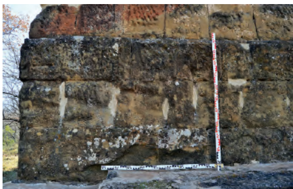
Fig. 11. Ermita de La Magdalena de Panzano. Muro norte y esquina noreste de la cabecera: detalle del aparejo original andalusí de sillares, con tizones, sogas y alzado escalonado por medio de retranqueos en el muro.
