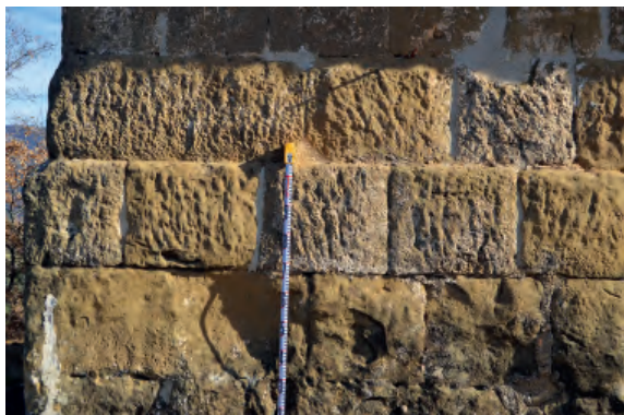
Fig. 13. Ermita de La Magdalena de Panzano. Muro oeste de la nave y esquina noroeste: detalle del aparejo original andalusí de opus quadratum , con sillares a tizón, sogas de esquina y terminaciones con almohadillado muy poco prominente alisado por medio de surcos de cincel y listel perimetral.
