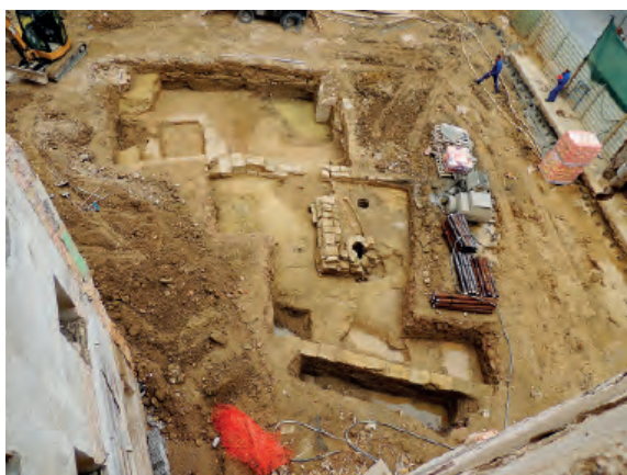
Fig. 32. Vista general del área excavada.
