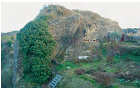
Fig. 19. Labata. Detalle del extremo norte de La Mota desde el noroeste. En primer término, el foso defensivo, hoy convertido en huerto, y a la izquierda de la imagen, en el vértice septentrional, el corte artificial en la roca que aislaba el extremo del reducto defensivo ante el valle del Calcón.
