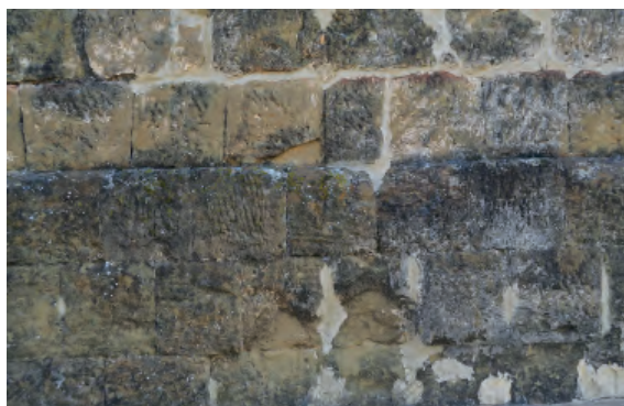
Fig. 12. Ermita de La Magdalena de Panzano. Muro norte de la cabecera: detalle del aparejo andalusí, con bloques a tizón, algunos de ellos de formas de tendencia poligonal, terminados exteriormente con almohadillado muy leve alisado por medio de surcos de cincel y listel perimetral.
