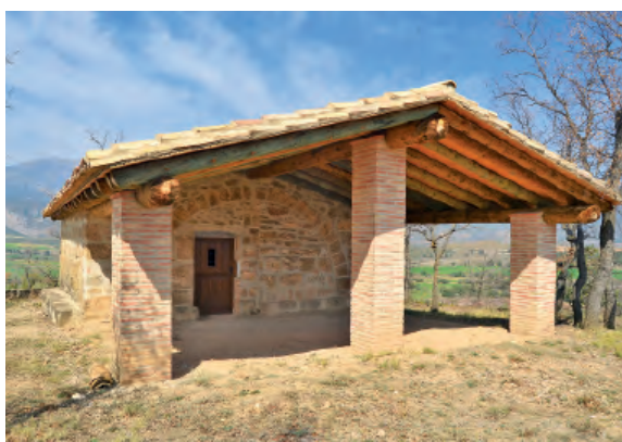
Fig. 5. Ermita de La Magdalena de Panzano desde el sur-suroeste, con el pórtico sobre pilares de ladrillo de los pies, fachada sur de mampostería con la puerta bajo arco ciego y nave de sillares al norte.
