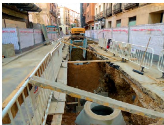
Fig. 2. Zanjas de grandes dimensiones abiertas en el Coso Bajo de Huesca para la sustitución de la red de saneamiento.
