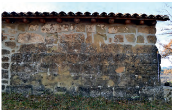
Fig. 9. Ermita de La Magdalena de Panzano. Muro oriental de la nave, en el que se aprecia la parte inferior del muro original de sillares.
