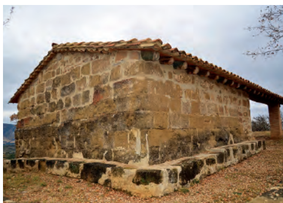
Fig. 6. Ermita de La Magdalena de Panzano desde el noroeste. Cabecera del templo en la que se aprecia el aparejo de sillares de gran módulo perteneciente a la torre defensiva andalusí. Obsérvese el banco adosado que impide apreciar el arranque de los muros primitivos.
