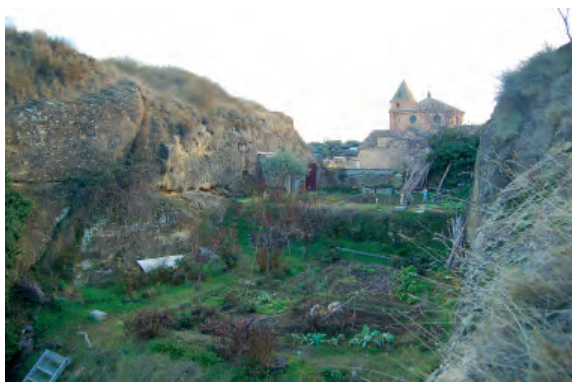
Fig. 21. Labata. Detalle del foso que defendía La Mota por el noroeste y la aislaba de la muela de Las Eras Altas. Obsérvese la disposición perfectamente vertical de sus paredes talladas en la roca y su notable amplitud. La pared oriental o escarpa se corresponde con la cara noroeste de La Mota, en la que se aprecian algunos entalles labrados en la arenisca. Hoy el espacio del foso se utiliza como huerto dividido en tres terrazas.
