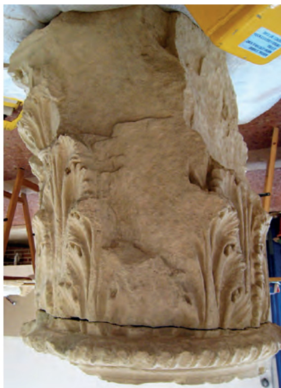
Fig. 26. Vista general de una de las caras peor conservadas del capitel corintio normal (a la derecha de la de la fig. 24), en este caso con la pieza inferior (astrágalo y sumoscapo), en la que se aprecian las importantes fracturas y mutilaciones de la pieza, producidas antiguamente suponemos que en el proceso de su expolio. Obsérvense la decoración de lengüetas del astrágalo y el breve tramo del sumoscapo liso, así como la escasa erosión de la decoración vegetal de las coronas, que demuestra que esta cara estaría mucho más protegida de los agentes erosivos en comparación con las anteriores.
