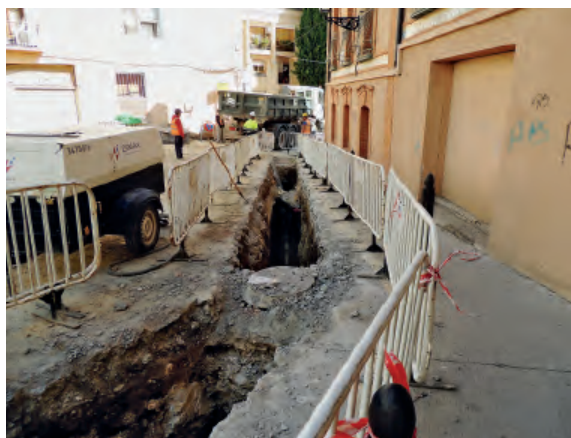
Fig. 11. Zanja de saneamiento en la calle Peligros.
