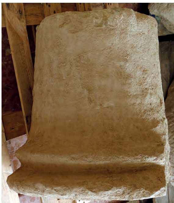
Fig. 20. Detalle de la basa, en el que se aprecia el alisado de una parte de esta para poder adosar la pieza a un muro. Obsérvese el tramo de unos 40 cm de fuste liso con ligera disminución, así como el perfil de la basa, con dos toros de alzado similar, el inferior de mayor diámetro, separados por una estrecha escocia de fondo plano enmarcada por dos listeles lisos.
