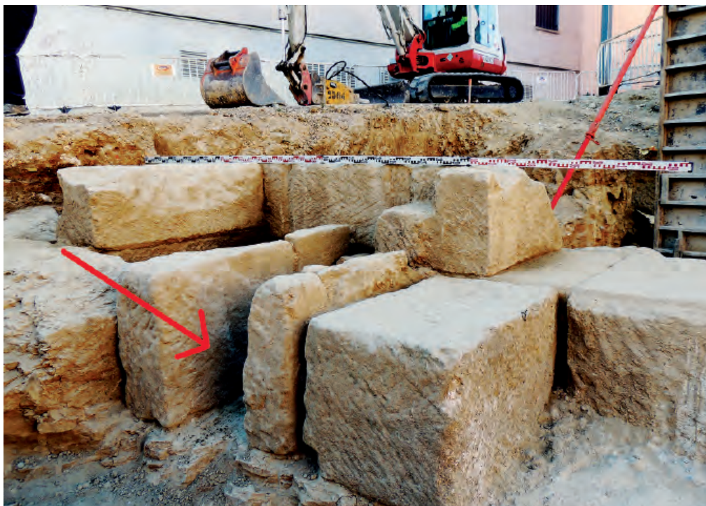
Fig. 9. UE 1200 desde el sureste. En primer término, los contrafuertes y el receptáculo identificado como arqueta de desagüe (flecha roja).
