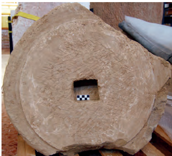
Fig. 19. Detalle de la cara inferior de la basa, muy bien conservada, en la que se aprecian perfectamente las técnicas de terminación de su superficie en el scamillus y en toro inferior, la mortaja y el tramo de unos 45 cm retallado de los toros.
