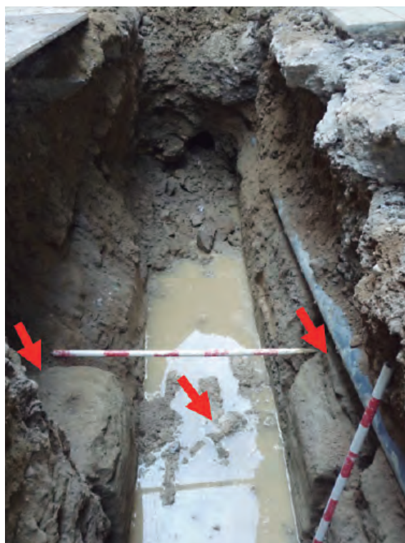
Travesía del Cedro. Detalle de sillares de muro de opus quadratum .
