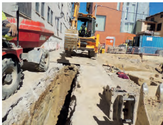
Fig. 12. Zanja abierta en la calle Desengaño.
