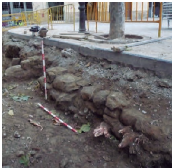
Detalle del muro de contención de la plaza de San Pedro.
