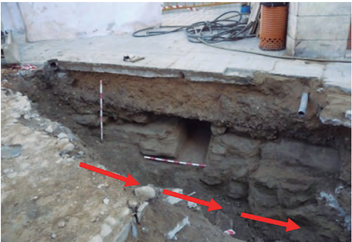
Detalle de la margen izquierda del canal abierto de saneamiento sobre estrato rocoso en la plaza de San Pedro. Las flechas indican la trayectoria del barranco antropizado.
