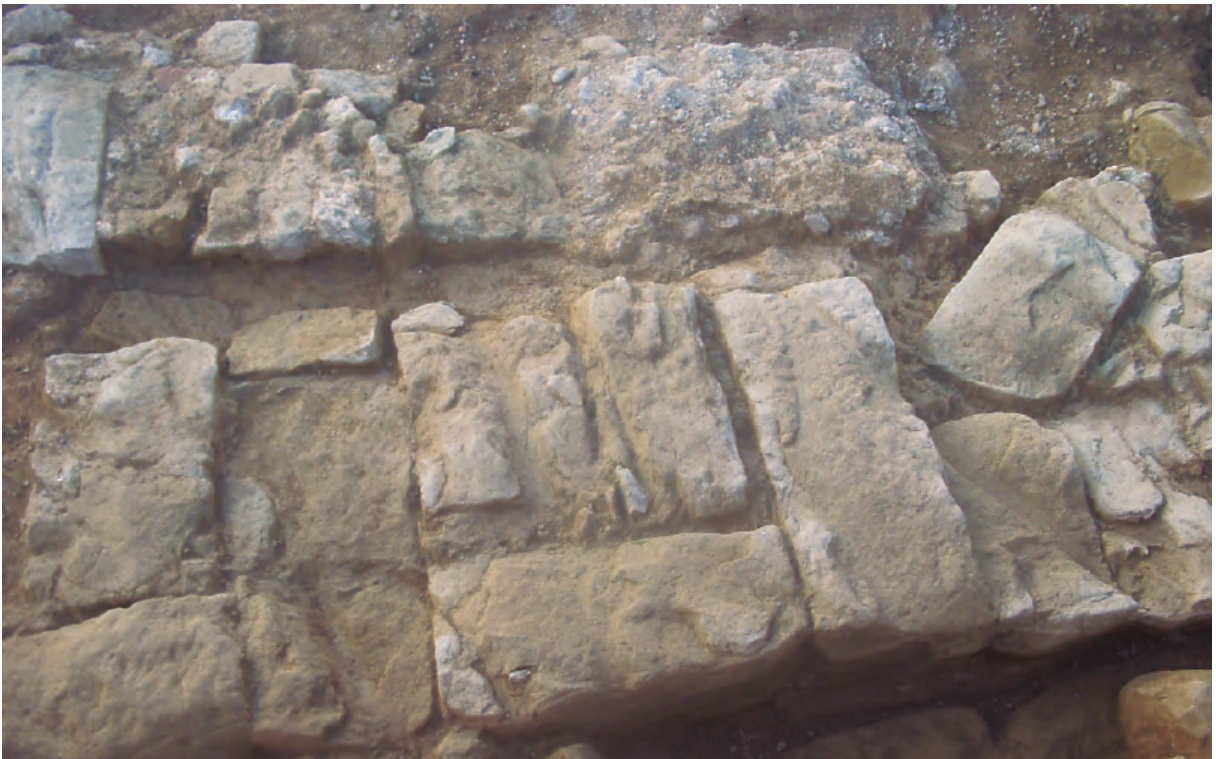
Fig. 33. Detalla del aparejo dispuesto a sogá y tizón del muro de época romana.
