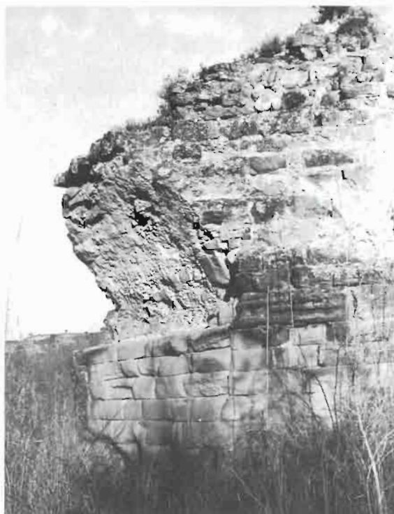
Lámina 4. Puente romano de Castejón.
