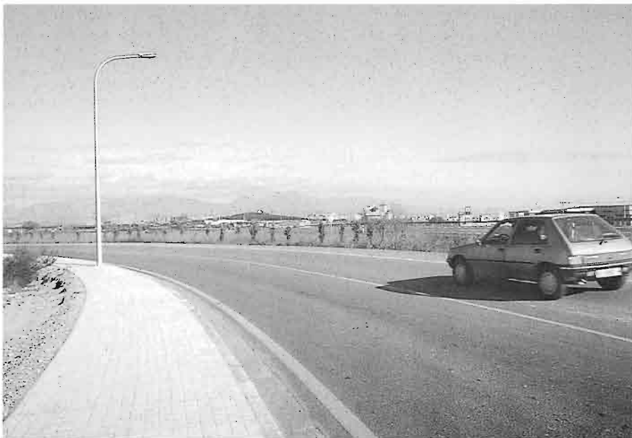
Fig. 15. Vía. Tramo VI. Trazado destruido por la variante de circunvalación.
