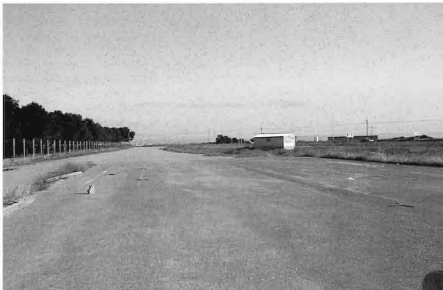
Fig. 13. Vía. Tramo IV. Asfaltado. Junto al Centro de Enseñanzas Integradas (tapia límite de la calzada).
