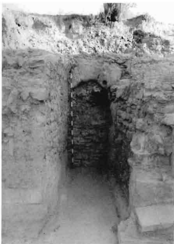
Lám. 4. Puerta clausurada con su arco, entre las salas 5 y 6.
