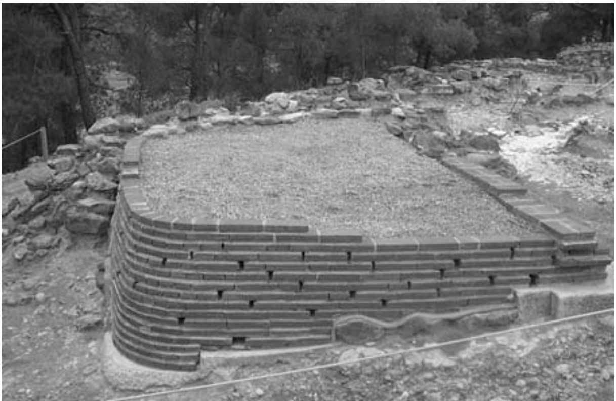
Fig. 3. Detalle de la torre una vez restaurada.
