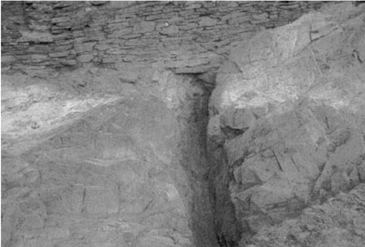
Fig. 1. Detalle del canal de desagüe de Pencia 2.
