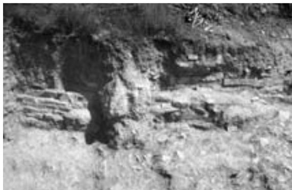
Fig. 5. Detalle del muro de protección de la ladera hecho con piedras calcáreas sobre el basamento de los bloques de grava cementada (J. Medina, Servei d'Audiovisuals del IIEI).
