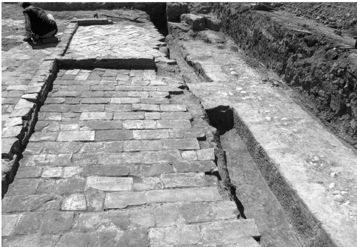
Fig. 22. Detalle del último pavimento del interior de la iglesia.
