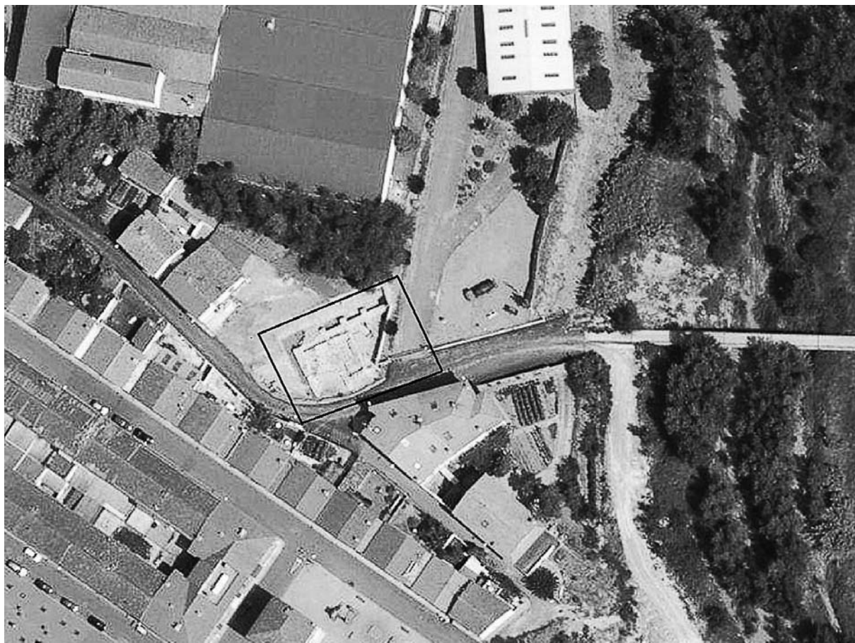
Fig. 1. Contexto urbano de la excavación (SITAR).
