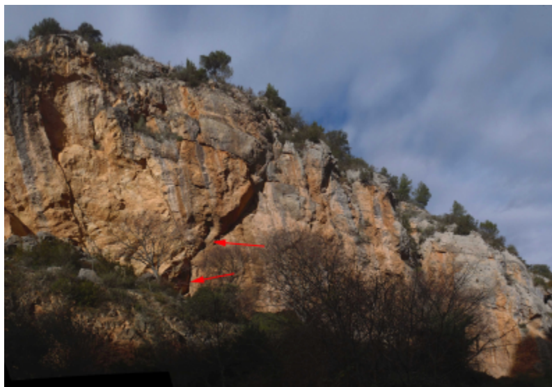
Fig. 6. Vista general de las grietas con estacas en Baldellou.
