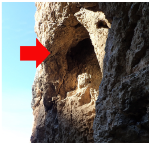
Fig. 11. Posición de la estaca en Olvena desde la boca.
