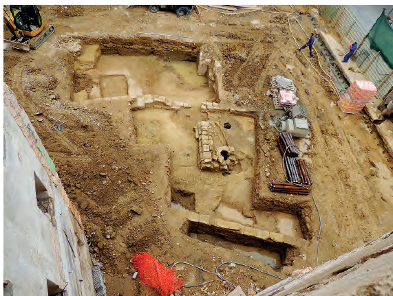
Fig. 32. Vista general del área excavada.
